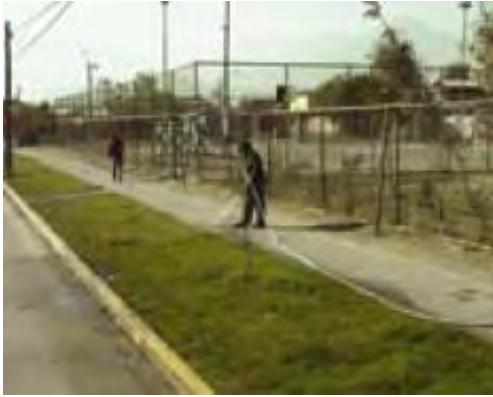
Figura 2.16: Vía de 2 estrellas para peatones (Fuente: iRAP, 2009c)
