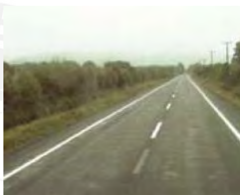
Figura 2.8: Vía de 2 estrellas para vehículo (Fuente: iRAP, 2009c)
