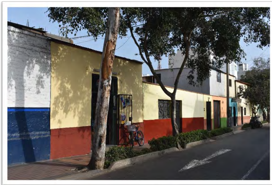
Figura 1. Viviendas de más de 40 años en el Barrio de Santa Cruz. Fuente propia
