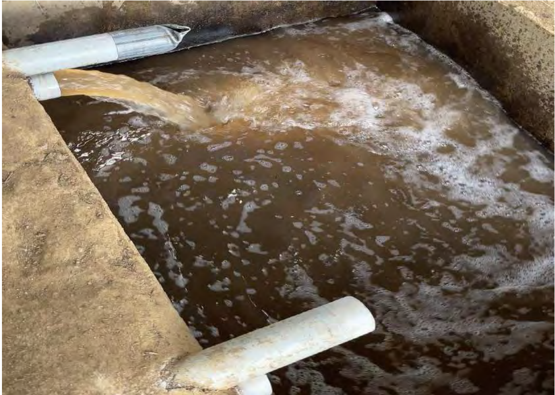
Drenaje luego del lavado
