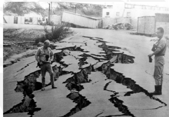
Grietas en la ciudad de Huaraz Foto: Asociaci6n Waras
