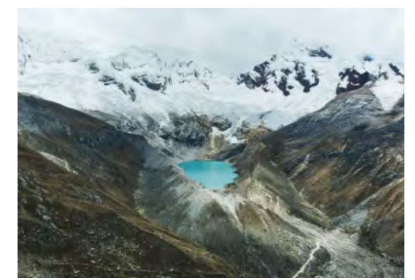
Laguna palcacocha , sub quebrada del Rio Quillcay ,en peligro de desborde
