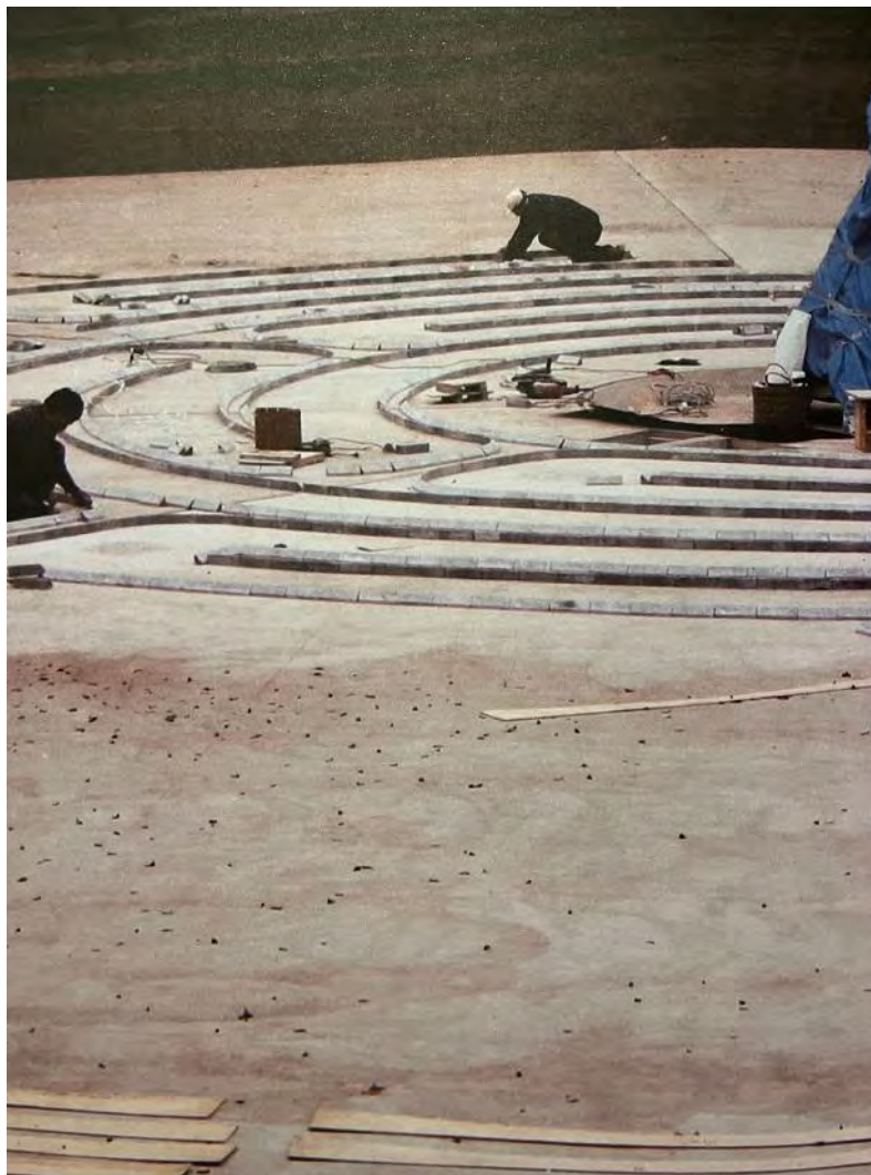
Fig.95 Proceso de instalación de El Ojo que Lloro.
