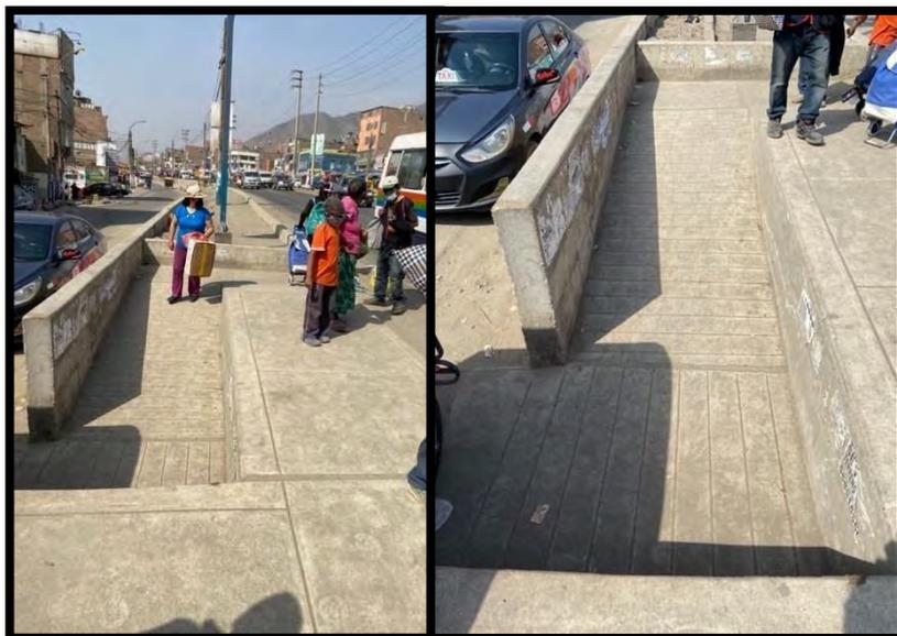
*Ilustración 39. Inadecuadas rampas peatonales*
