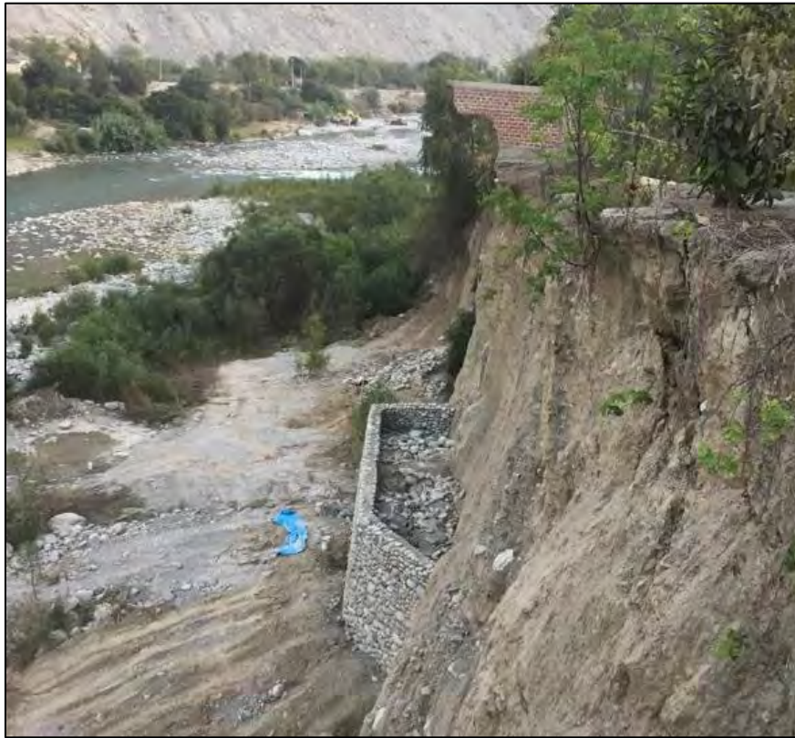
Figura 16. Fotografía de muro de contención gestionado y financiado por vecinos de Catapalla, 2022. Fotografía de la autora.
