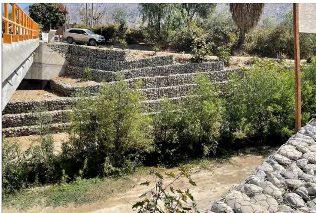
Figura 18. Fotografía de puente y muros de contención sobre quebrada en Catapalla, 2022 5 . Fotografía de la autora.
