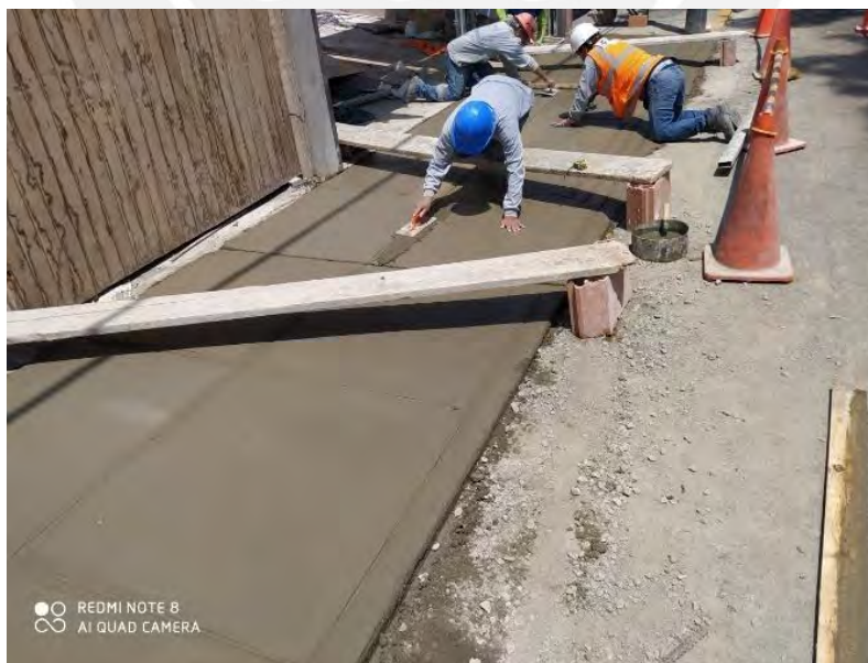
Imagen 20: Obras externas (vereda)
