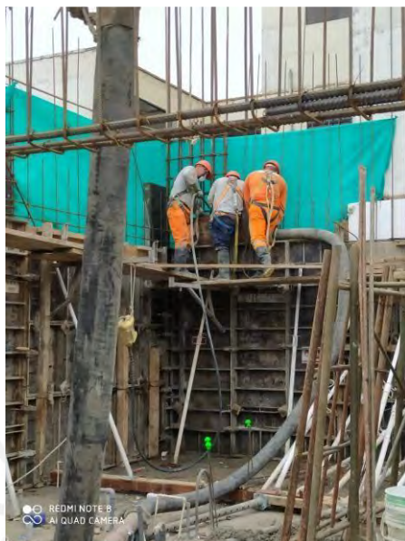
Imagen 03: Vaciado de placa - PL03
