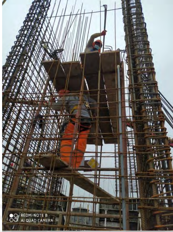
Imagen 01: Instalación de acero para placa –PL 03
