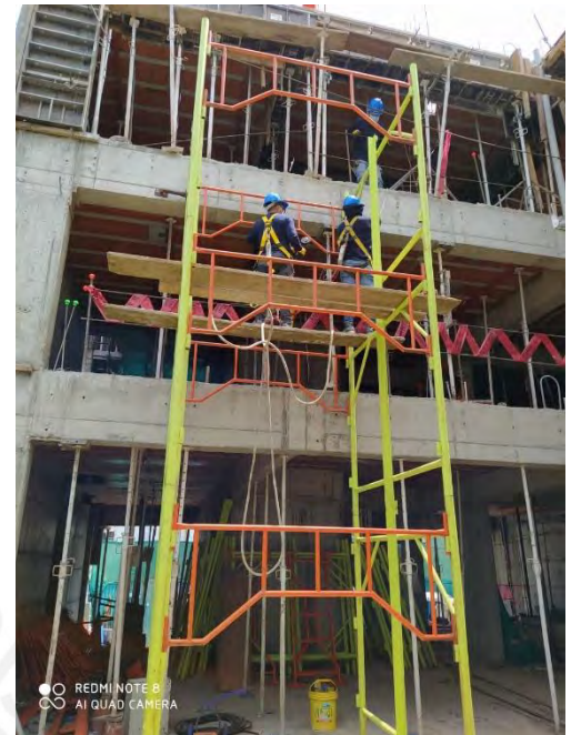
Figura 43: Ubicación del elevador montacarga para transportar los materiales y equipos (Fuente propia)
