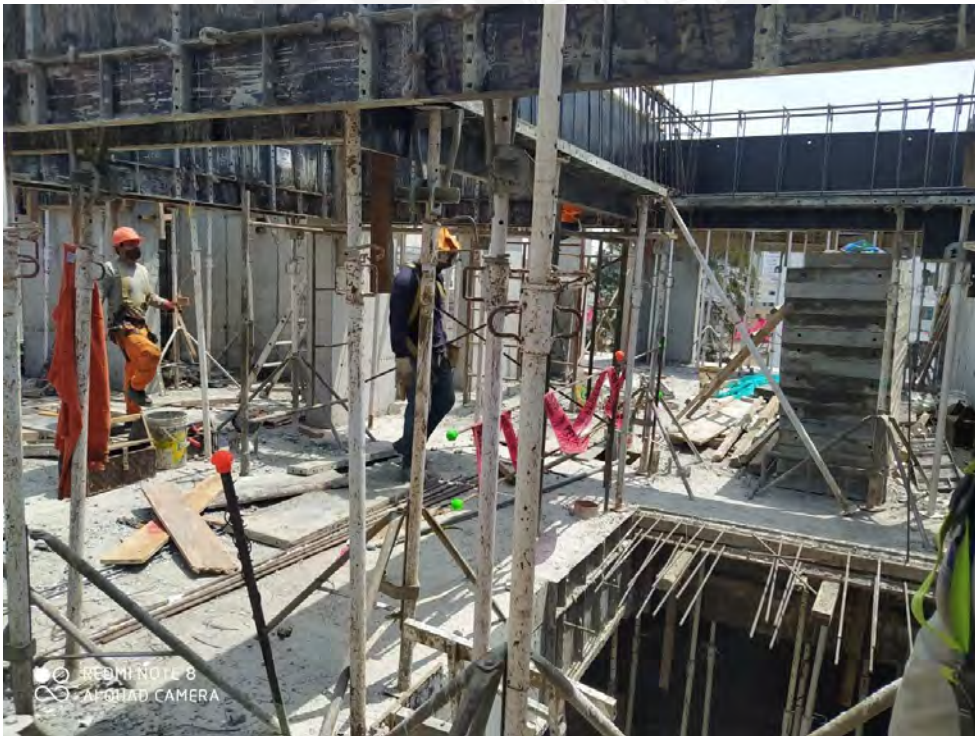
Imagen 06: Encofrado de vigas sector 1
