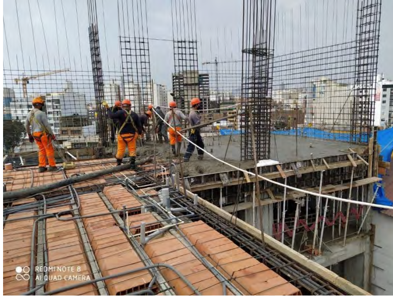
Imagen 09: Vaciado de elementos horizontales
