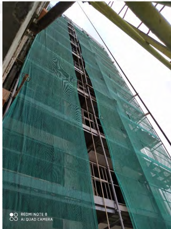
Imagen 18: Instalación de andamio para fachada
