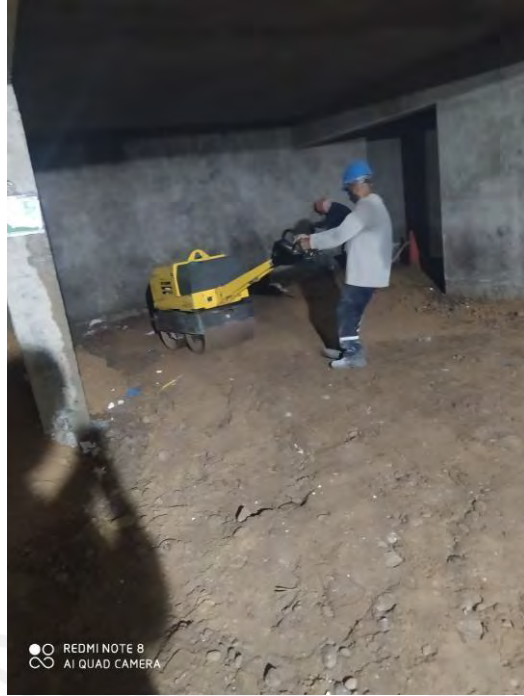
Imagen 17: Compactación de terreno para el vaciado de piso en sótano
