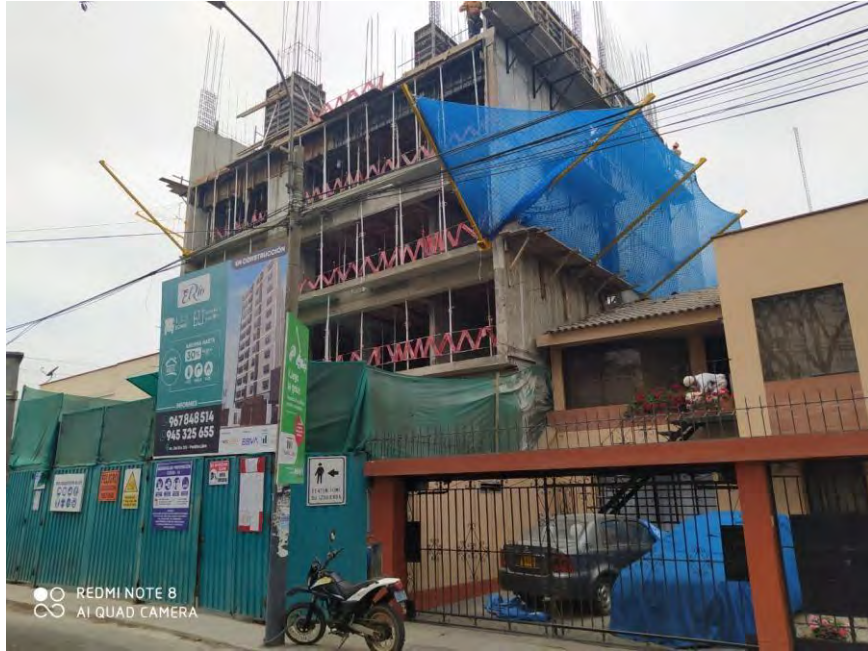
Imagen 04: Instalación de monta carga para subir material a todos los niveles
