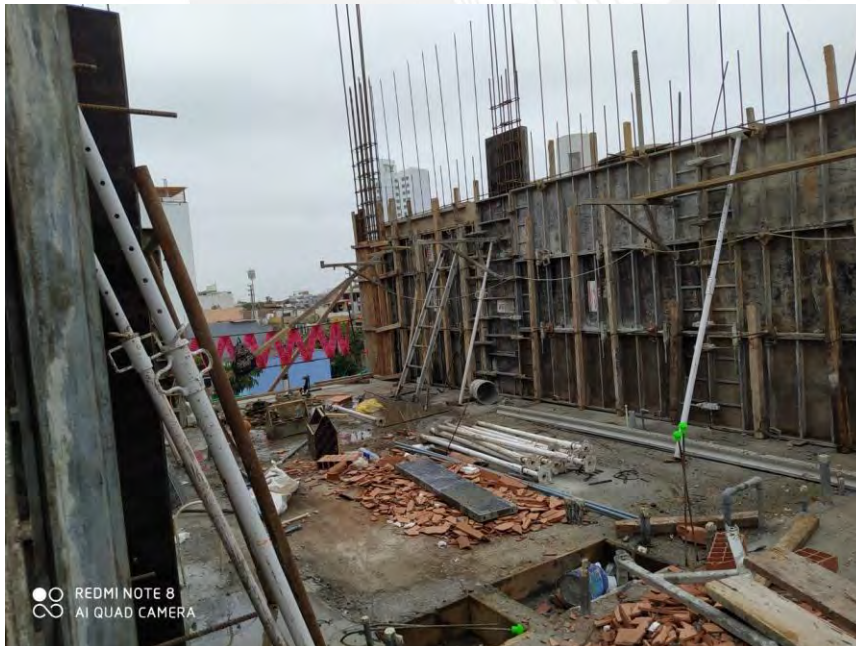
Imagen 02: Encofrado de placa - PL 03
