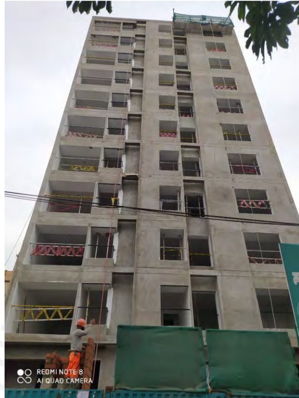
Imagen 19: Tarrajeo de fachada frontal
