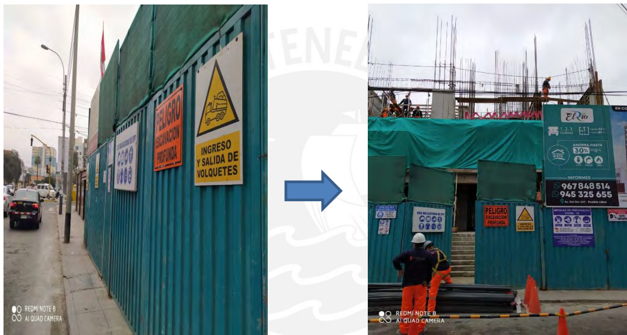
Figura 37: Ingreso al proyecto “El Río” (Fuente: Propia, 2020)
