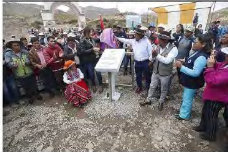
Asfaltan 6 kilómetros del tramo I de carretera Viscachani en Caylloma
