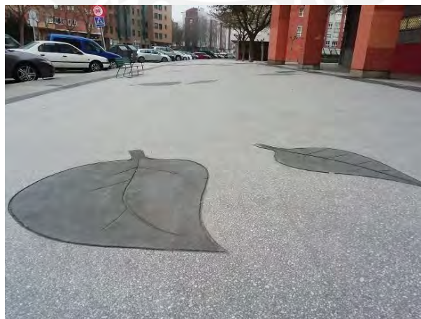
Figura 39. Acabado fundido pulido para aceras en Ayuntamiento de Burgos, España.
