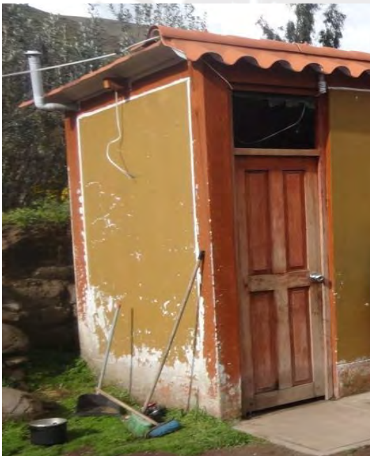
Ilustración 11 Exterior baño domiciliario PRONASAR
