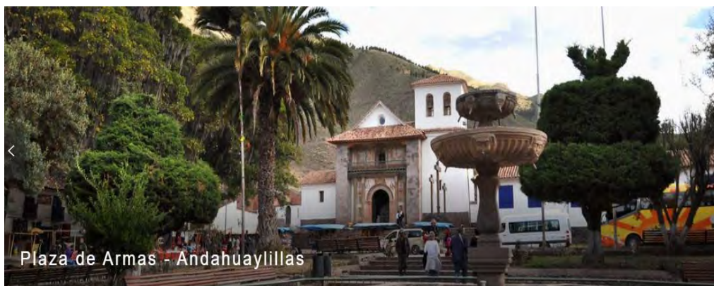
Figura 2. Plaza de Andahuaylillas
