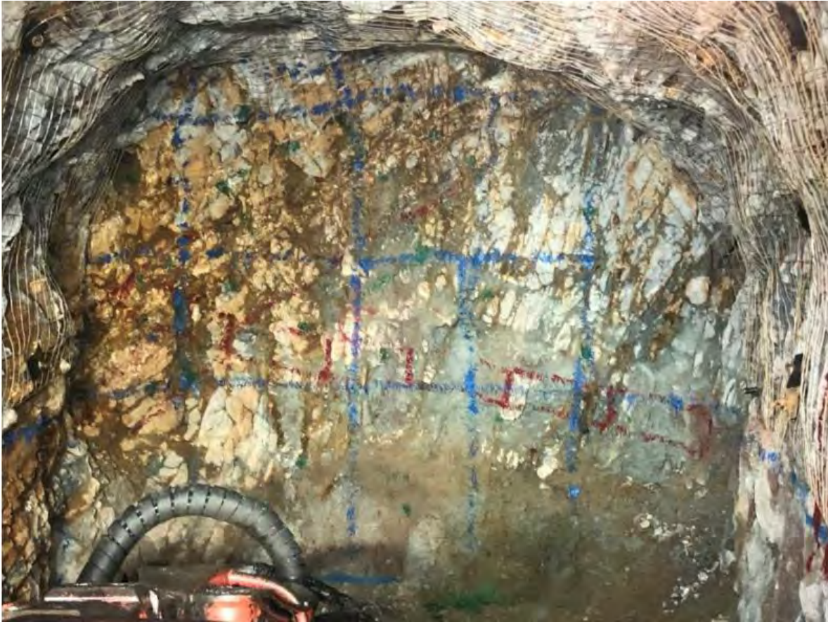
Figura 1. Malla de perforación dentro de la mina subterránea Pallancata
