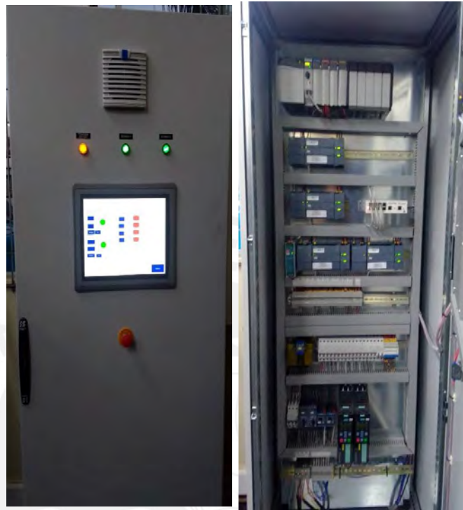
Figura 2. 2 Tablero de mando y supervisión para Planta piloto de transportes de fluidos. Fuente: Elaboración propia
