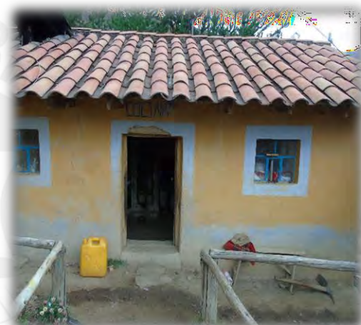
Foto 52: Vista de ingreso a cocina mejorada.
