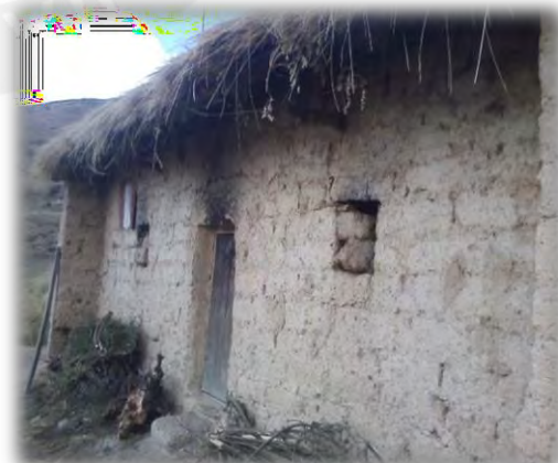
Foto 12: Vivienda en Llama.
