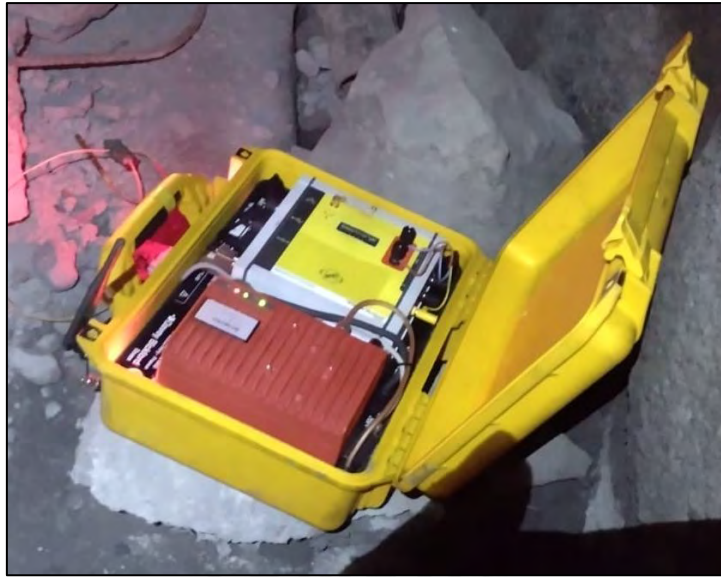
Figura 46. Instalación del equipo DBD en interior mina.
