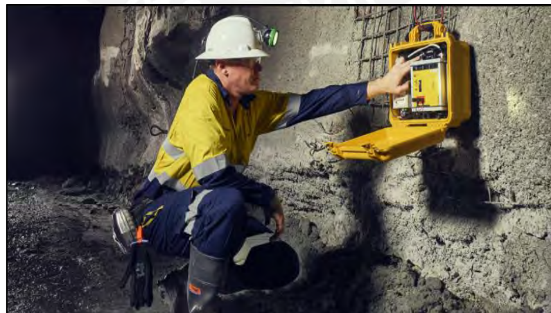
Figura 17. Equipo de iniciación electrónica en mina subterránea.
