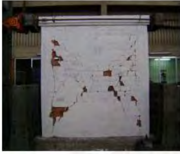
Figura 43. Estado final del muro sin refuerzo ensayado por Barr y Pineda Tomada de “Control de la trituración de los ladrillos huecos mediante malla de refuerzo en muros de albañilería confinada sujetos a carga lateral cíclica”, por Barr & Pineda, 2011
