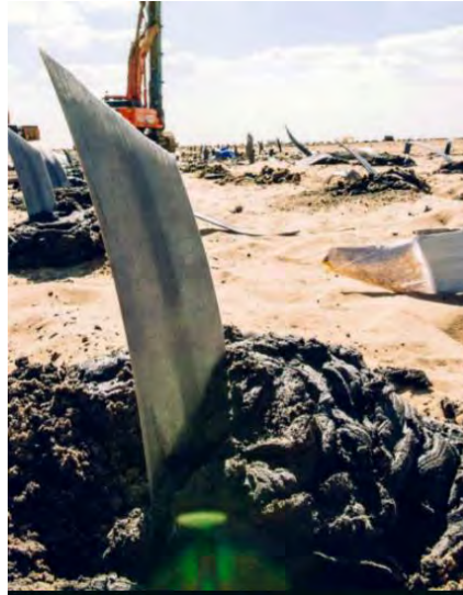
Figura 3.8. Mecha de 20cm. Fuente: Keller Cimentaciones (2018).
