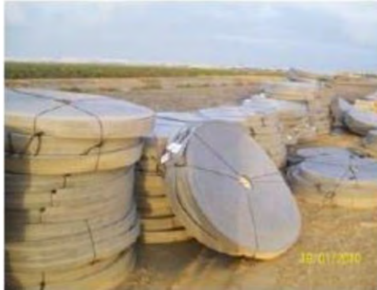
Figura 3.4. Lotes de mechas drenantes. Fuente: Menard (2018).
