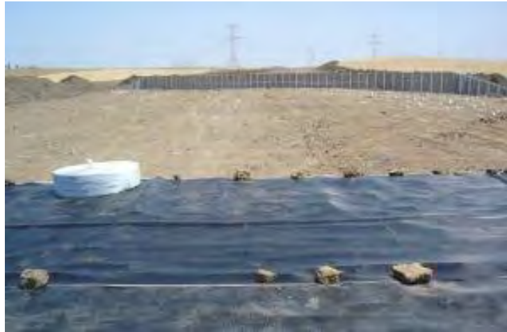
Figura 3.5. Colocación de la capa de geotextil sobre la capa de precarga. Fuente: Geosintéticos Ferrero Soto (s.f.).
