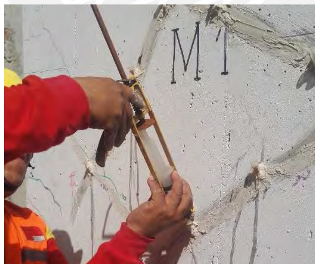
Figura 38. Reparación mediante inyección epóxica.
