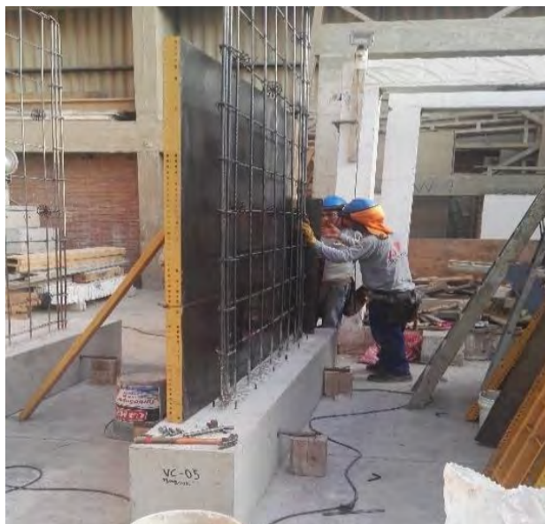
Figura 40. Reposición del muro.
