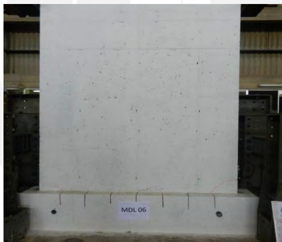
Figura 32. Muro en estado de daño límite 1.
