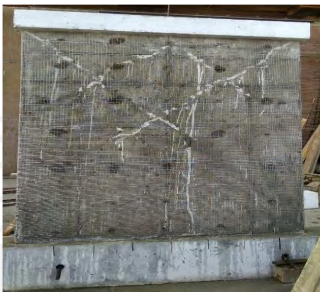
Figura 39. Reforzamiento mediante malla eletrosoldada.
