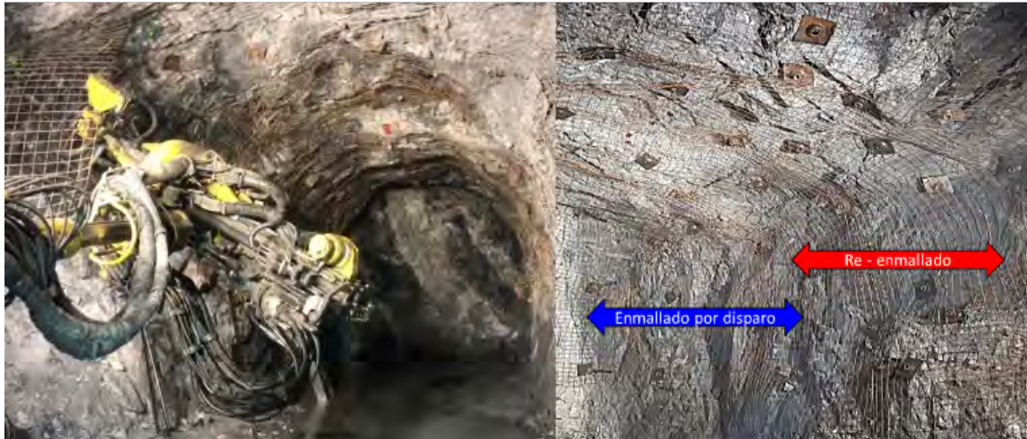
Figura 12 Re sostenimiento por los equipos Boltec S
