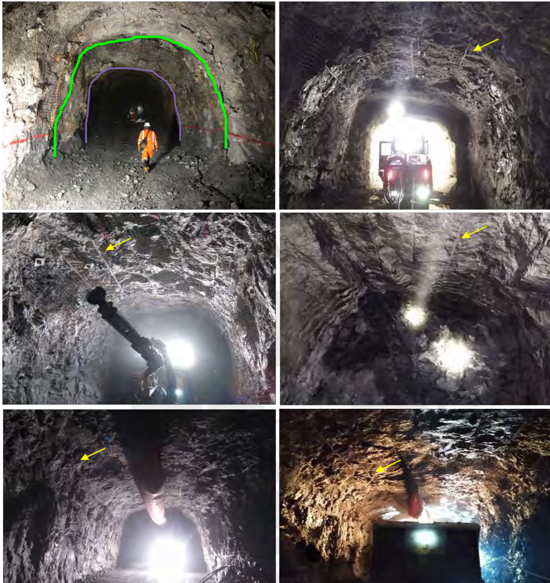
Figura 18 Evidencias de resultados de control de sobre excavación.
