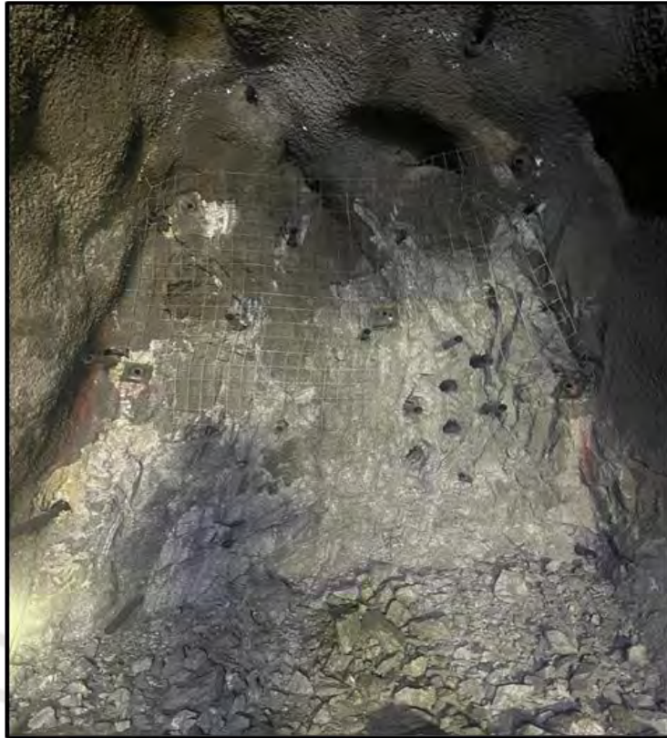
Figura A14: Malla de perforación
