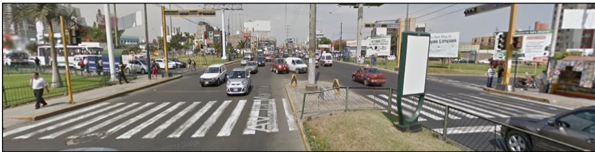
Figura 39: Tramo que muestra elevada accidentabilidad
