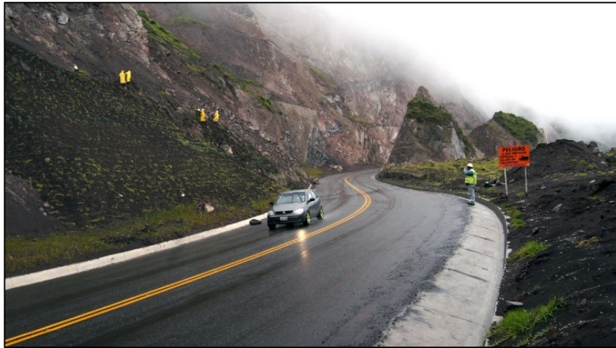
Figura 8: Demarcaciones en el pavimento. Fuente: Google Imágenes
