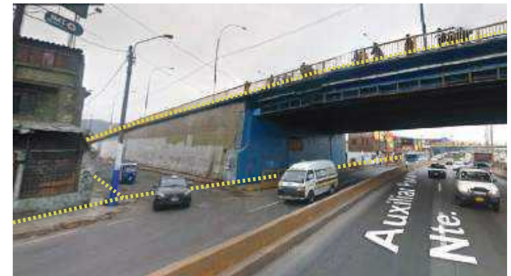
Vista del Puente Prolongación Tacna sobre la Av. Evitamiento. Fuente: Google Street View, 2014.
