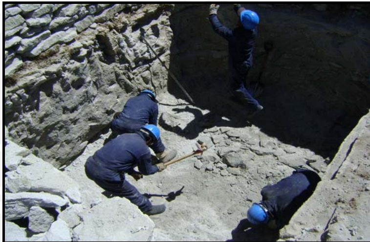
FIGURA 2.6. Poza de sedimentación
