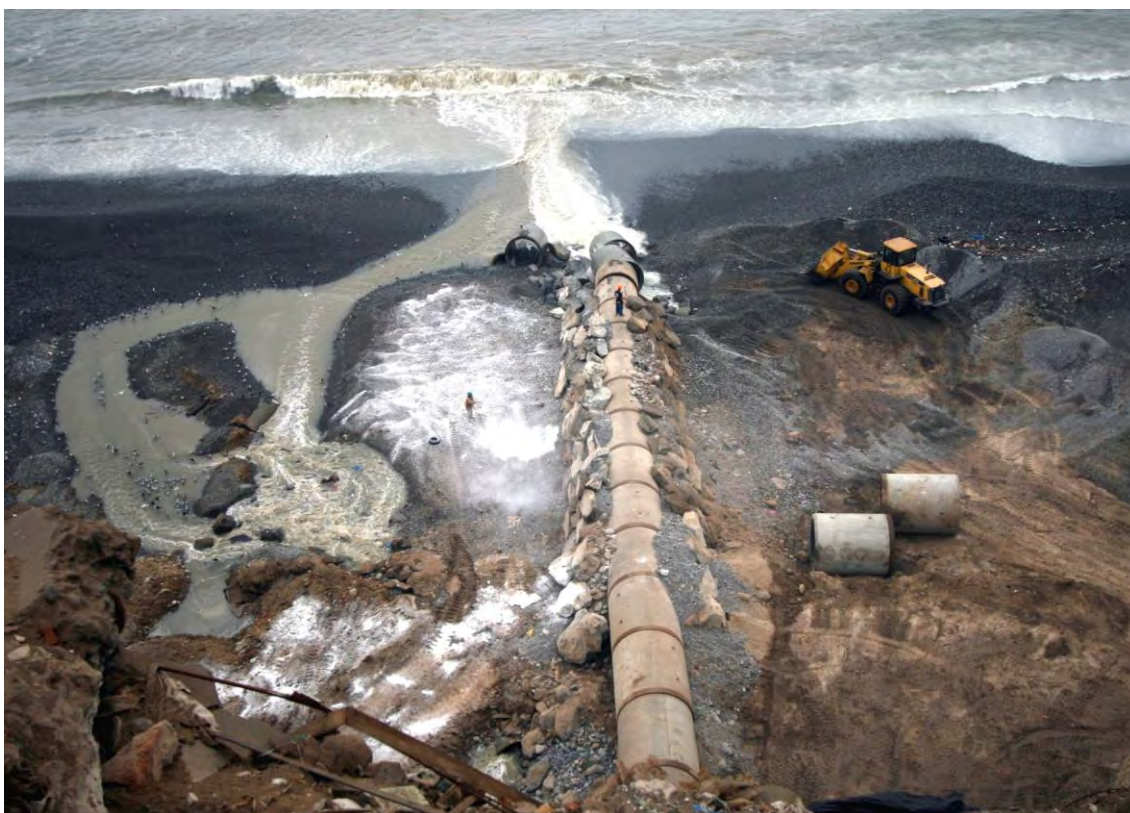
Fotografía 6. Trabajos en el colector costanero de San Miguel.
