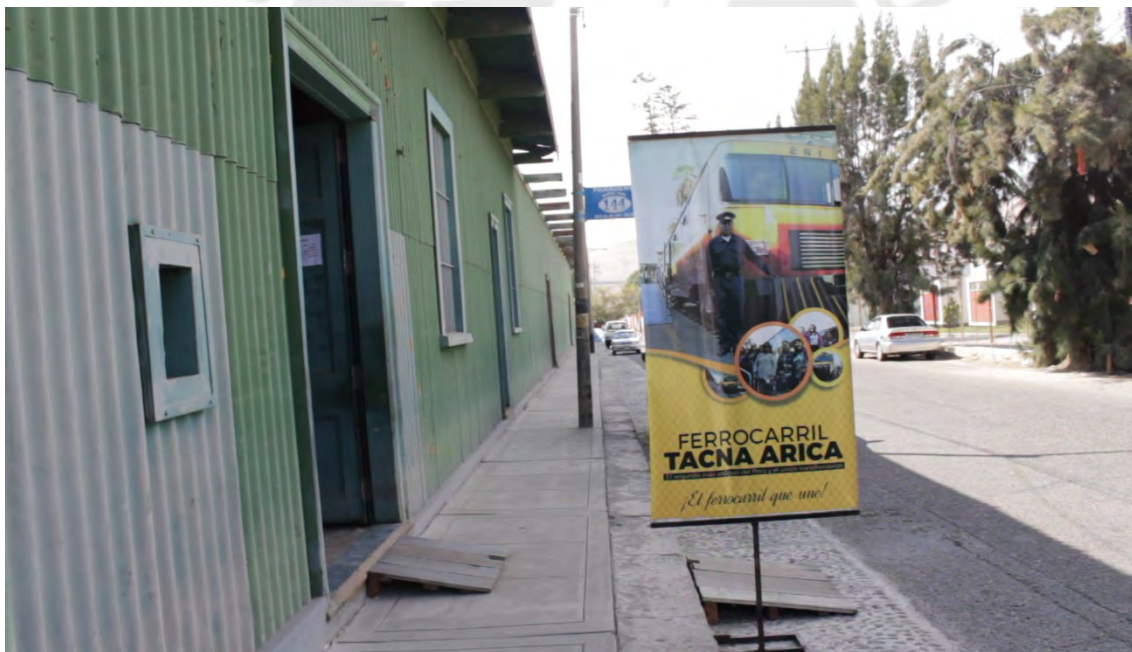
Figura 4. Fachada de la estación en la ciudad de Tacna del Ferrocarril Tacna – Arica. Foto del autor, 2019.
