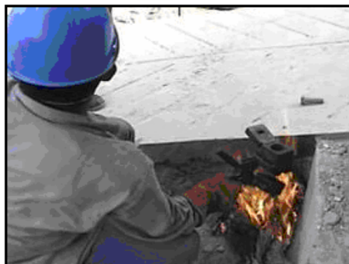
Figura 42: Proceso de soldaduras Exotérmicas.
