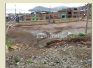
CANCHAS EN DETERIORO
