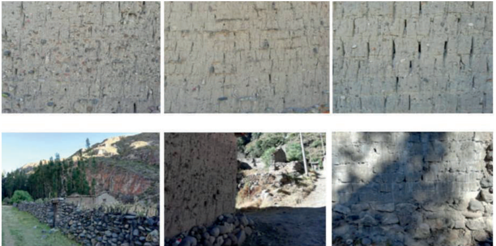
Fig. 55 Distintos tipos de mezcla de tierra y barro, o de piedras, dependiendo de la distancia al río. Los muros más cercanos presentan piedras de canto rodado, los más alejados van mostrando piedra partida de canteras en el cerro. Fotografías del autor, 2018.
