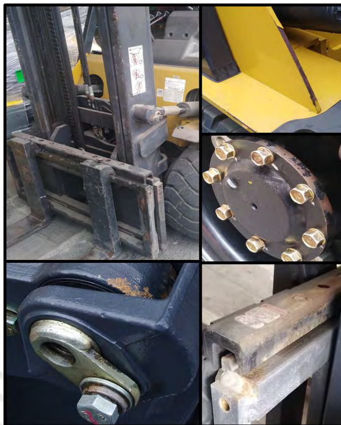
Figura 27 Partes oxidadas de montacargas
