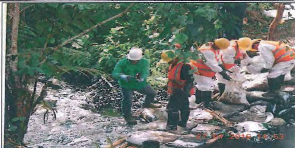
Foto 08: Muestra los trabajos que viene realizando la empresa PETROPERÚ instalando barreras de contención en el cauce de la quebrada Inayo, aguas abajo del punto del derrame. Además, se observa a un especialista del OEFA tomando muestras de agua superficial en la mencionada quebrada.
