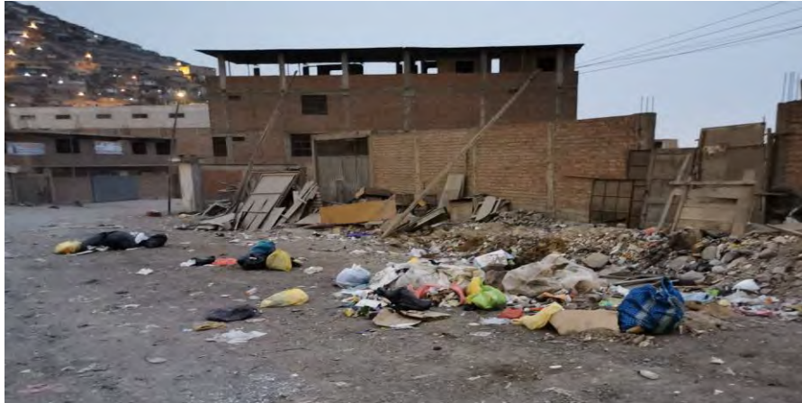
Figura 5.4. Punto crítico en San Juan de Miraflores, Pamplona Alta
