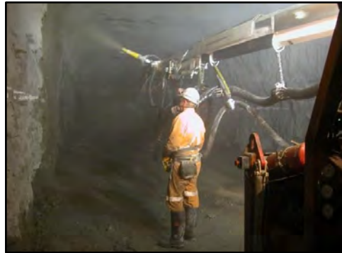
Figura N° 24 Lanzador operando en una mina subterránea
