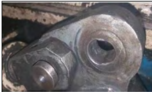
Figura N° 60 Desgaste en bocina de brazo de accionamiento.
