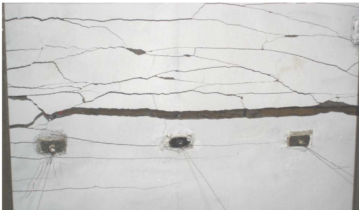
Fig 34: Vista Frontal del Muro 2 con desplazamiento máximo de 50mm
