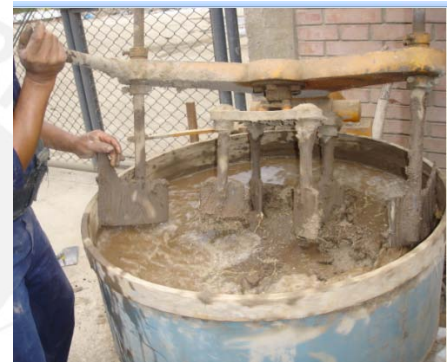
Fig 3: Preparación de Mortero
