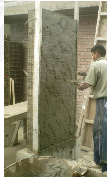
Fig 9: Tarrajeo del muro
