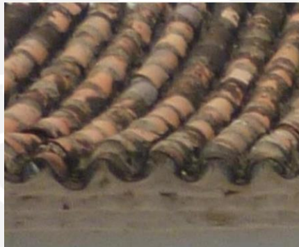
Figura 2.25 – Techo de tijeral de madera con cubierta torta de barro con cubierta de teja (La Torre, 2017)
