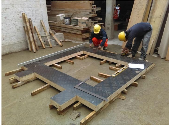
a) Instalación del encofrado
