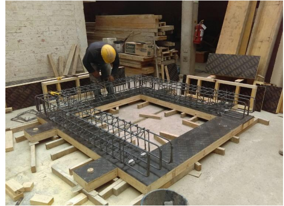
b) Montaje de la armadura
