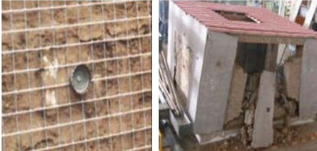
a) Detalle de refuerzo b) Esquinas de módulo reforzado con malla electrosoldada
