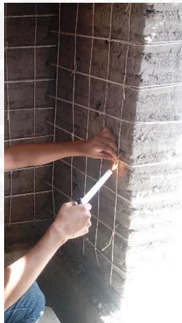
Figura 5.23 - Quemado de puntas del reforzamiento interior en módulo de adobe
