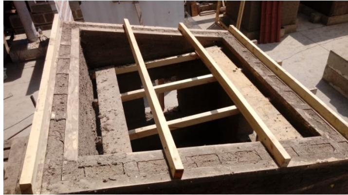
Figura 5.17 - Correas para soporte del techo
