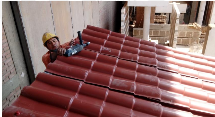
Figura 5.18 - Instalación de teja andina
