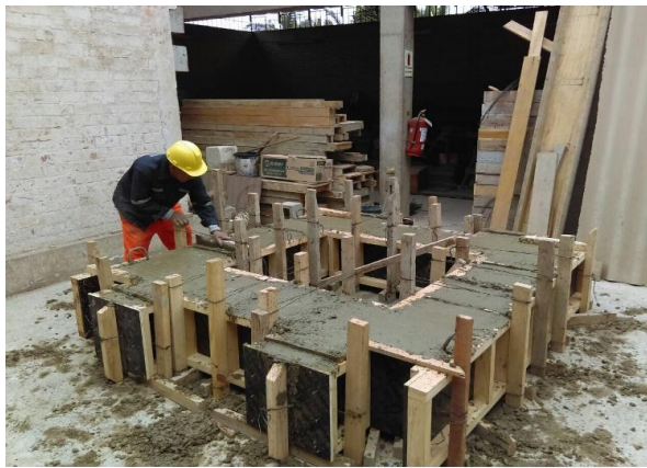
c) Acabado del concreto luego del vaciado
