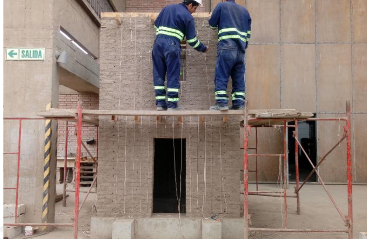
Figura 5.22 - Colocación de la cuerda vertical en el módulo de adobe
