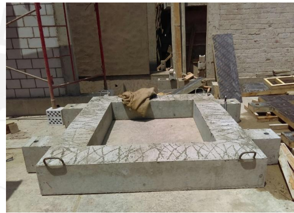
d) Anillo de cimentación finalizado
