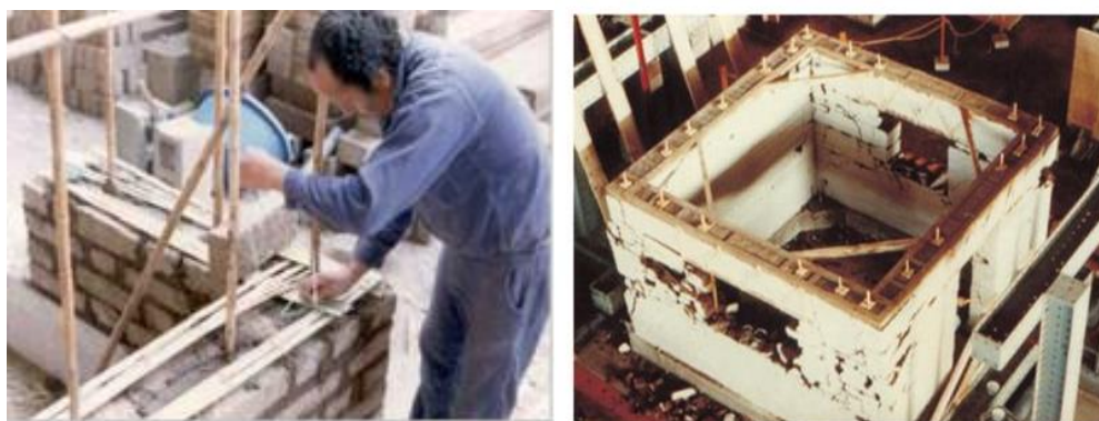
a) Instalación del refuerzo b) Módulo de adobe reforzado con caña luego del ensayo sísmico
