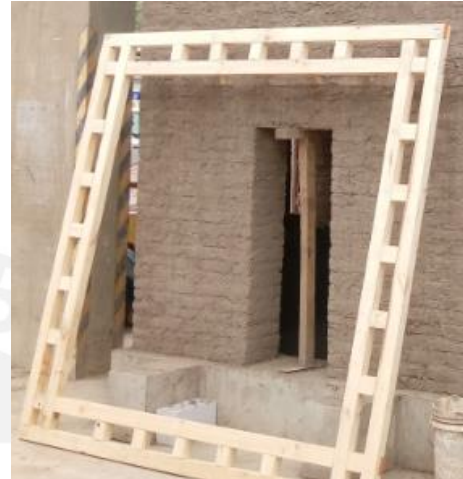
b) Viga collar finalizada
