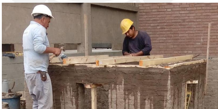
Figura 5.16 - Instalación de viguetas en el segundo nivel
