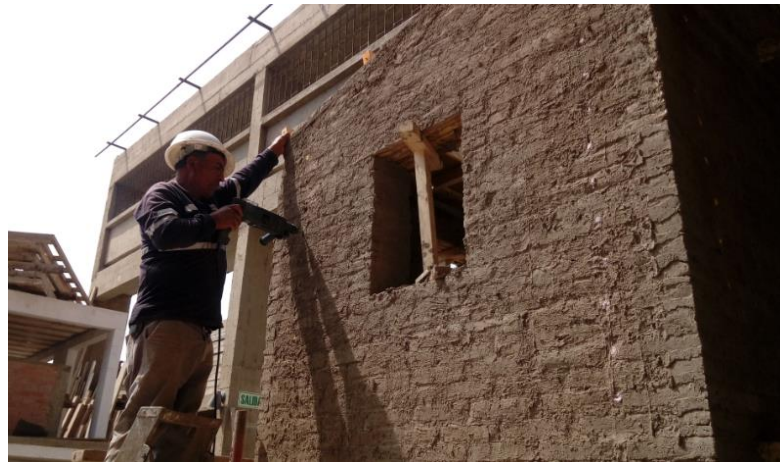
Figura 5.19 - Perforación para el refuerzo de driza
