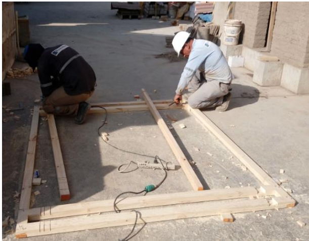
a) Construcción de la viga collar
