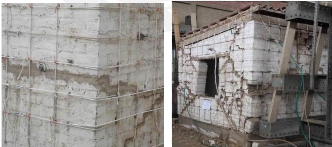
a) Detalle de refuerzo b) Módulo reforzado con malla de cuerdas ( D_0=0.13m )
