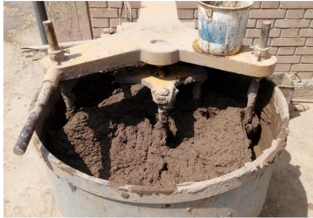
Figura 5.13 - Preparación de mortero para juntas de adobe
