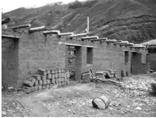
Figura 2.24 – Vivienda típica de adobe sin viga collar ni arriostres (Tarque et al., 2010)
