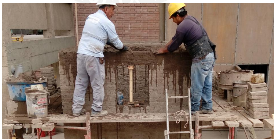
Figura 5.14 - Asentado de bloques de adobe en segundo nivel
