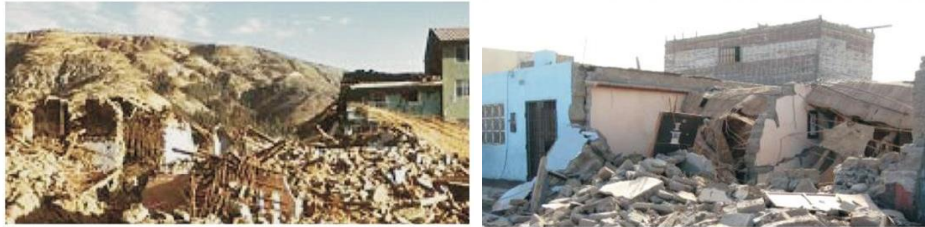
a) Colapso de estructura en Huaraz, terremoto 1970 b) Colapso de estructura en Pisco, terremoto 2007
