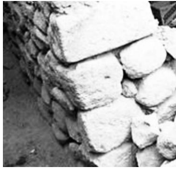
Figura 2.22 – Vivienda de adobe con sobrecimiento sólo de piedra (La Torre, 2017)
