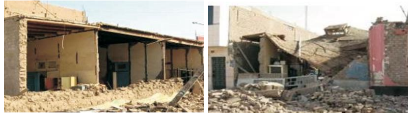
a) Colapso de fachada
