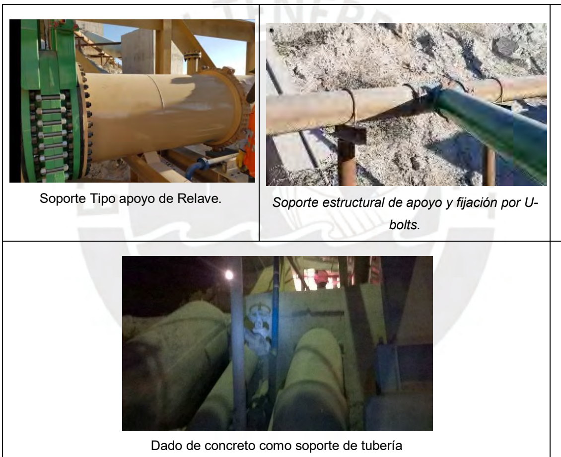
Figura 3-5: Soportes más usados en la industria minera en servicio de pulpa. Unidad Minera de Cuajone
