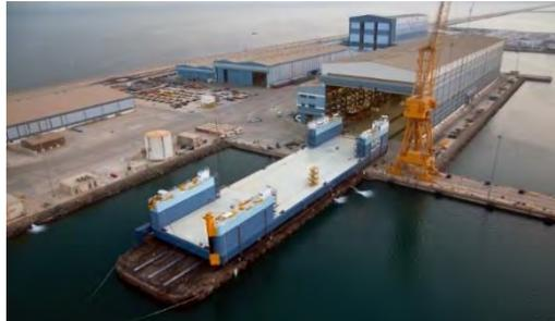
*Figura 1.3. Ejemplo de dique flotante y seco. (Dique seco flotante, 2020)*
