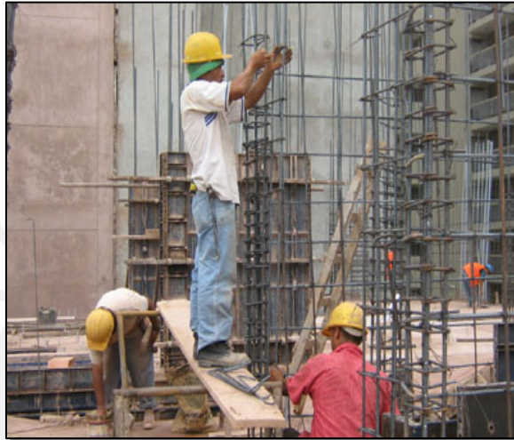
Foto3. Ferreros trabajando en la obra (Cortesía Constructora Toscana S.A.C.)
