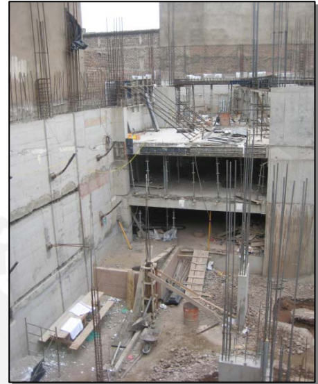
Foto 3. Vista del Proyecto (Cortesía Inmobiliaria LAPPSA)
