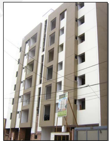
Foto 2. Vista del Proyecto (Cortersía Constructora Toscana S.A.C.)
