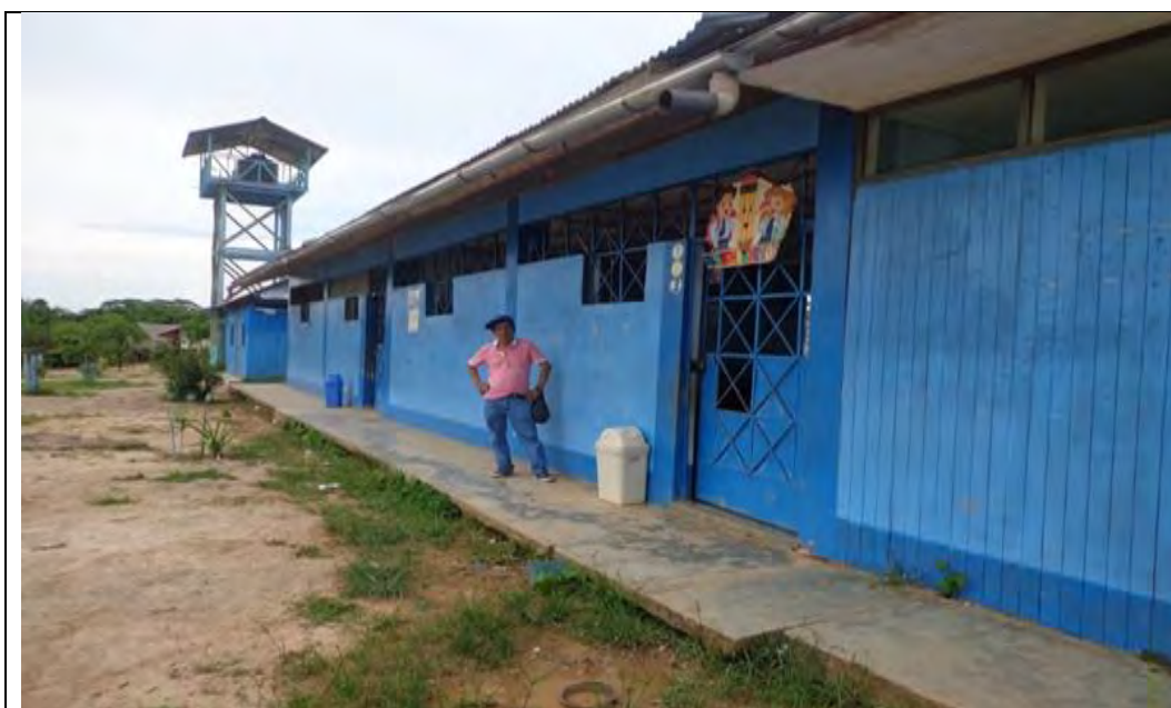
Vista de la infraestructura las I I.EE. de nivel Inicial y primaria del centro poblado de Vinuncuro
