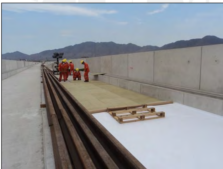
Fotografía: Colocación de sistema Antivibratorio Rock Ballast-Rock Delta Fuente: Informe mensual de Supervisión
