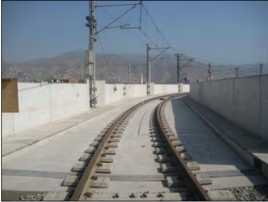
Fotografía: Entrada a Patio de Maniobras (Vista hacia progresivas descendientes) Fuente: Informe Mensual de Supervisión de Obra
