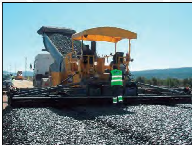
Figura 4.2: Colocación de balasto con Spreader
