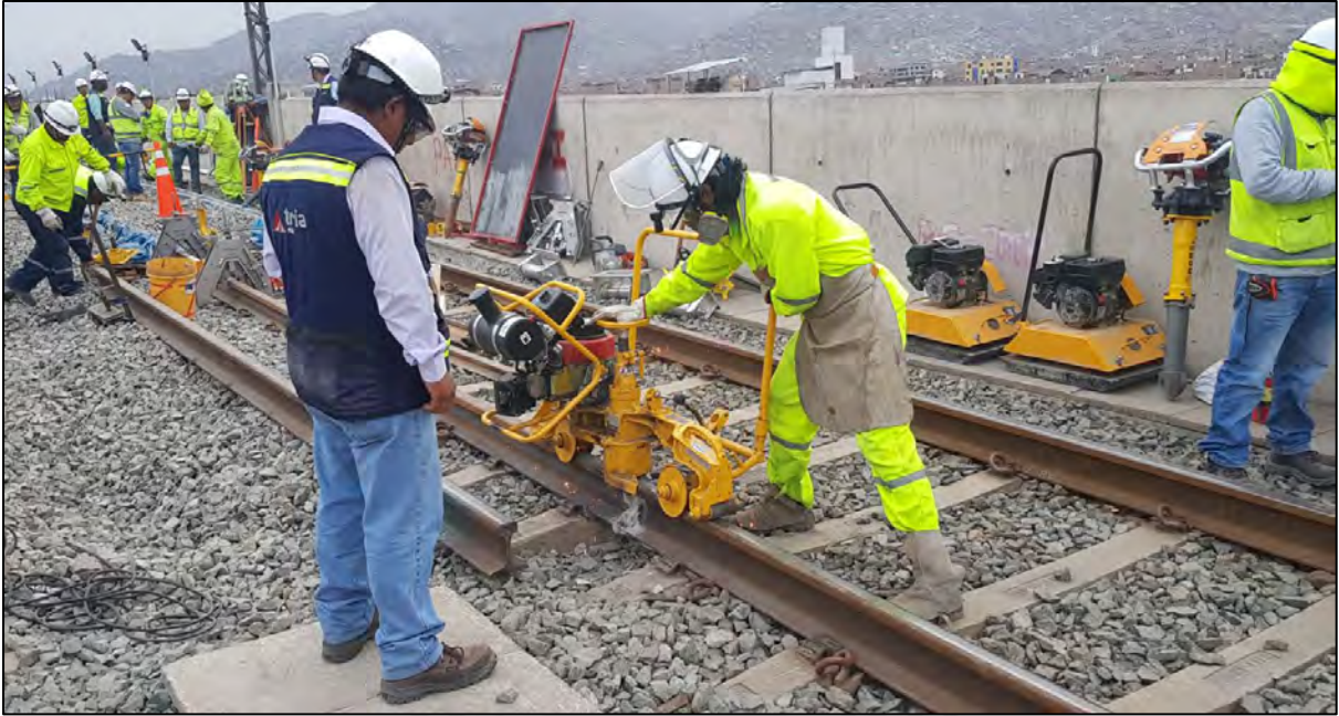
Fotografía: Esmerilado de riel Fuente: Tría Ingeniería
