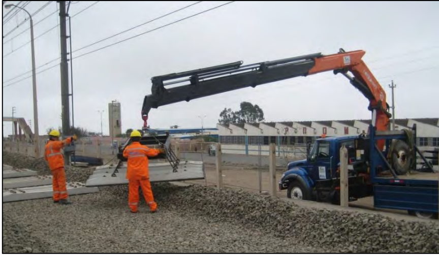
Pre posicionamiento de durmientes (Superficie) Fuente: Informe mensual de Supervisión
