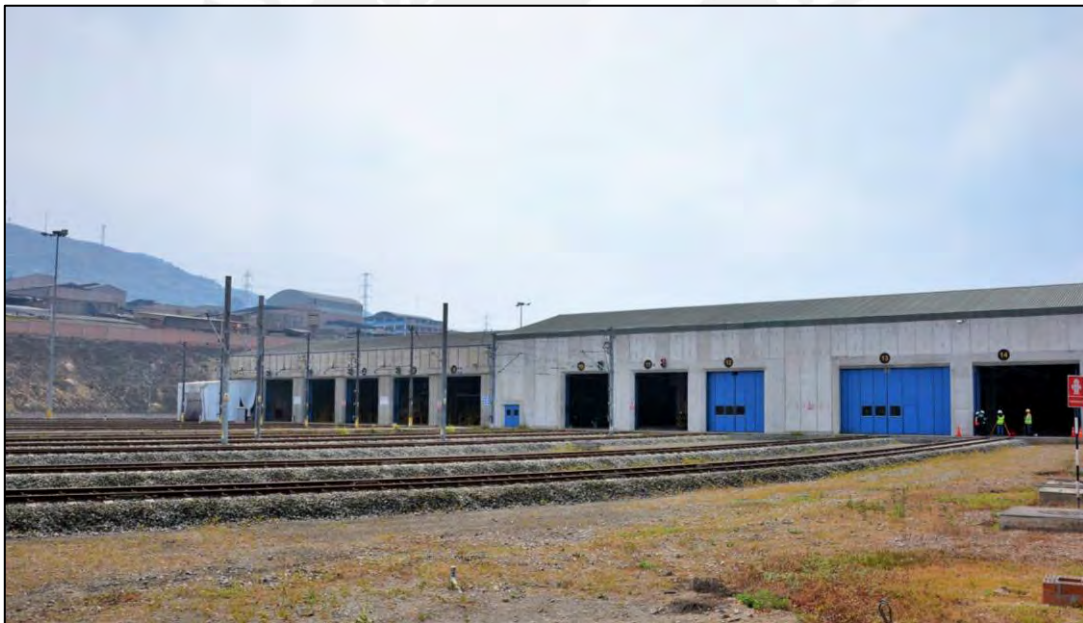
Fotografía: Exterior Taller de Mantenimiento Material Rodante
