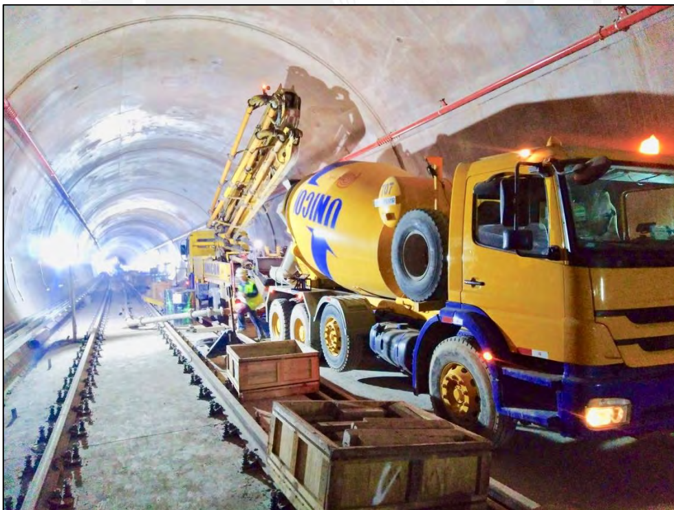
Fotografía: Camión y bomba de concreto en túnel Fuente: Metro de Lima y Callao - News
