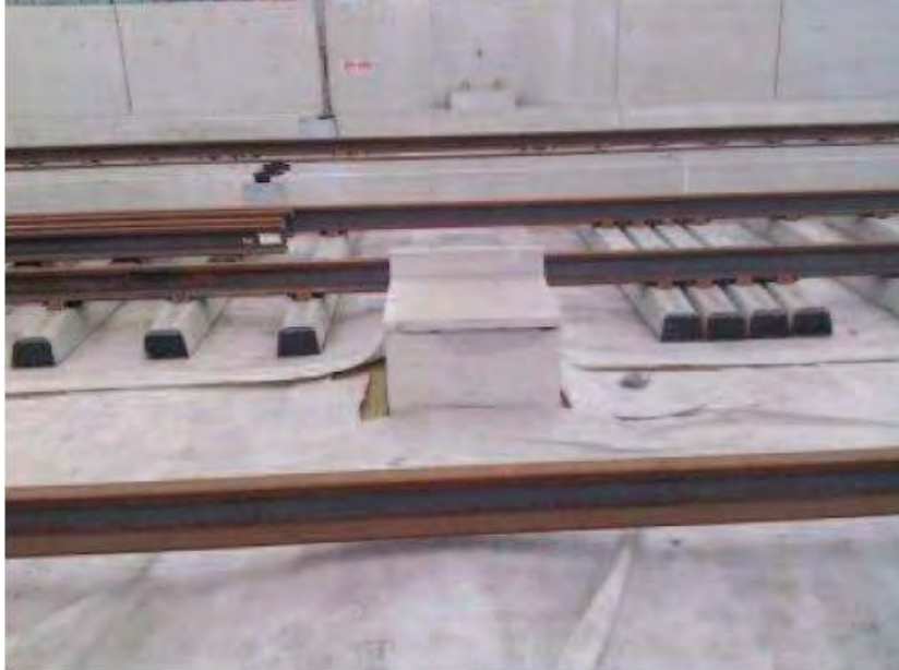
Fotografía: Sistema Antivibratorio Rock Ballast-Rock Delta instalado
