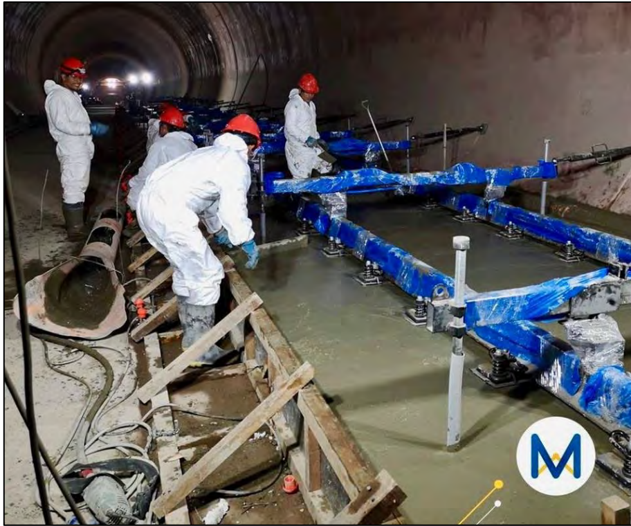
Fotografía: Vaciado de Concreto Fuente: Metro de Lima y Callao - News
