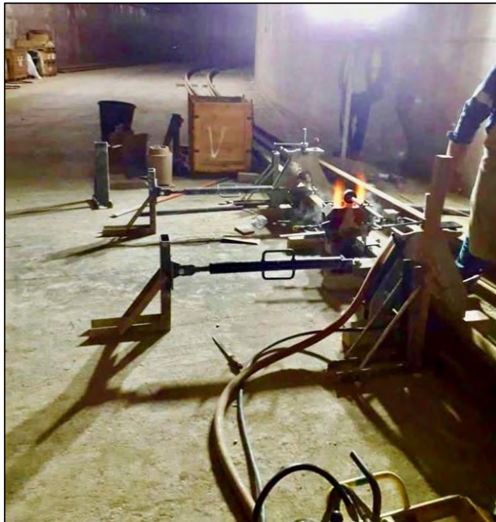
Fotografía: Soldadura aluminotérmica en banco de trabajo Fuente: Metro de Lima y Callao - News
