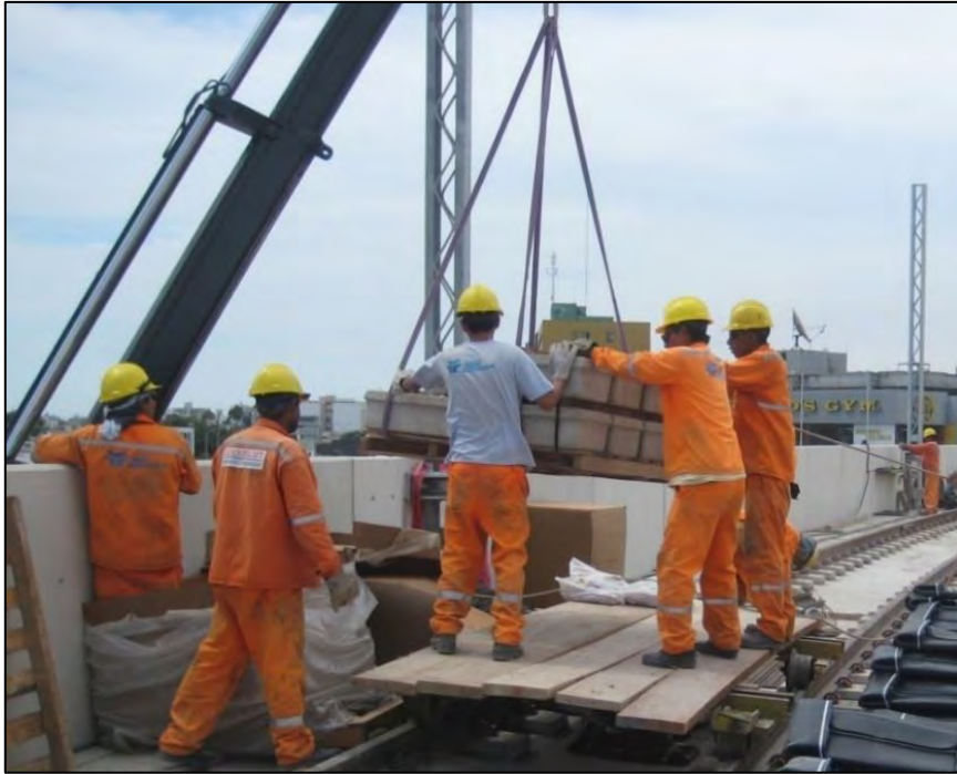
Fotografía: Izado de Bloques de Concreto Fuente: Informe Mensual de Supervisión de Obra
