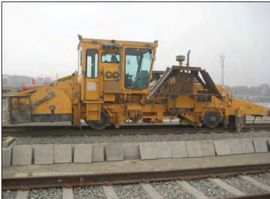
Fotografía: Perfiladora de balasto Fuente: Informe mensual de Supervisión
