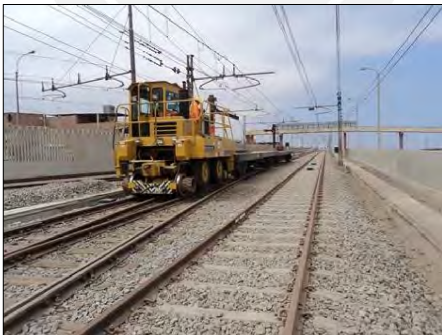
Fotografía A9.2: Tren de remolque Titan Fuente: Informe mensual de Supervisión
