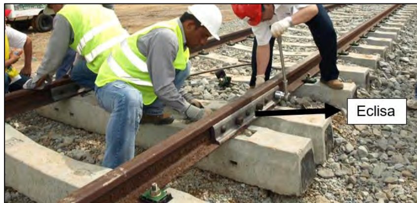
Figura 4.6: Colocación de eclisa provisional
