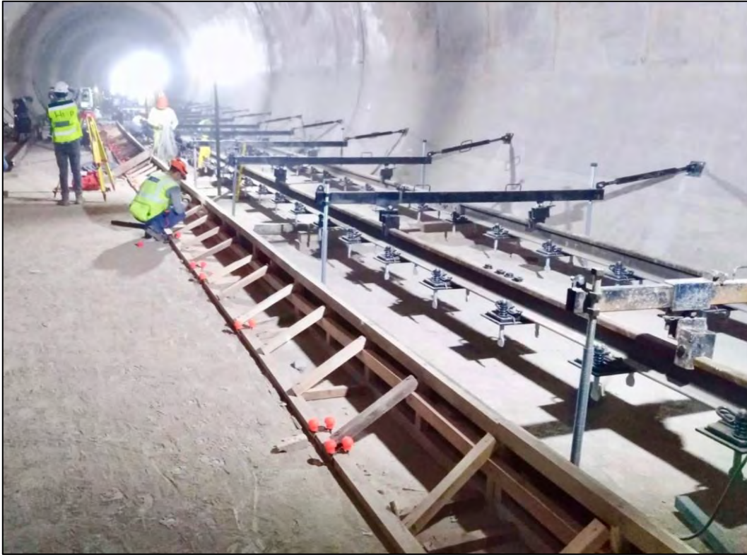
Fotografía: Encofrado Lateral Fuente: Metro de Lima y Callao - News
