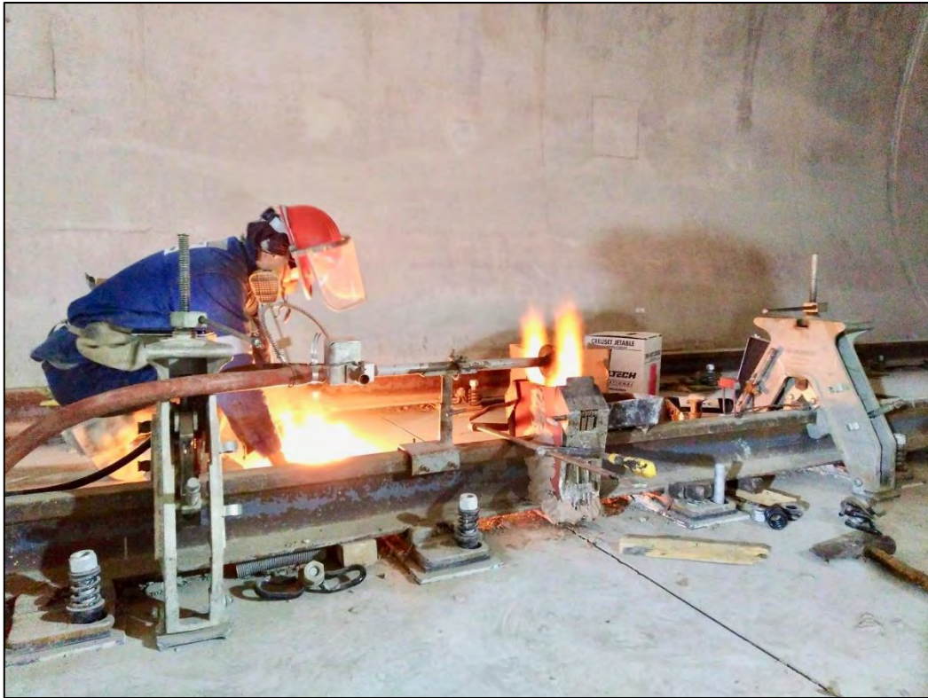
Fotografía: Soldadura Aluminotérmica Fuente: Metro de Lima y Callao - News
