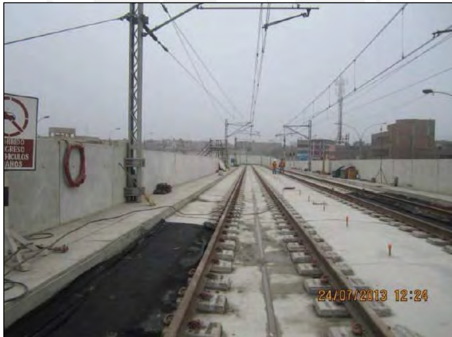
Fotografía: Curado de concreto Sistema Sonneville LVT Fuente: Informe Mensual de Supervisión de Obra
