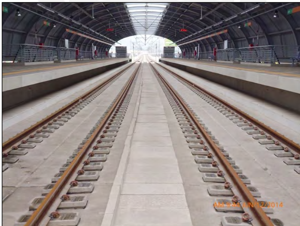
Fotografía: Sistema Sonneville/LVT en Estación San Carlos
