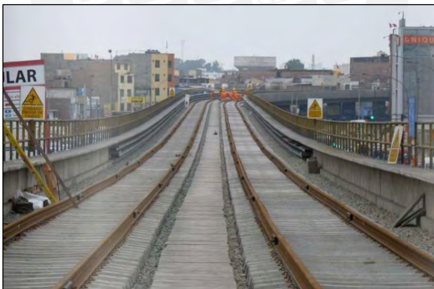
Fotografía: Escalera Pre-alineada, antes de completar balasto
