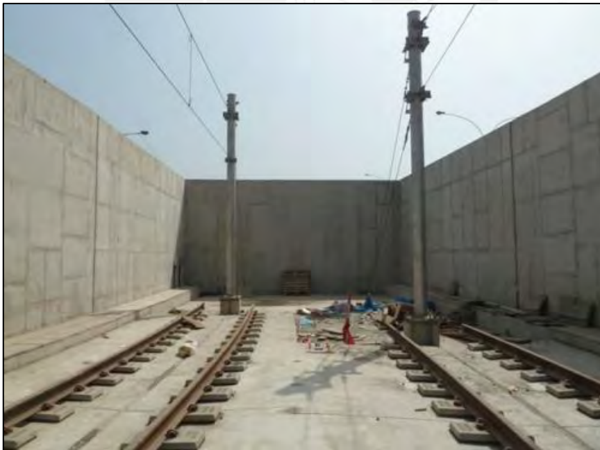
Fotografía: Final de cola de vía Fuente: Informe Mensual de Supervisión de Obra
