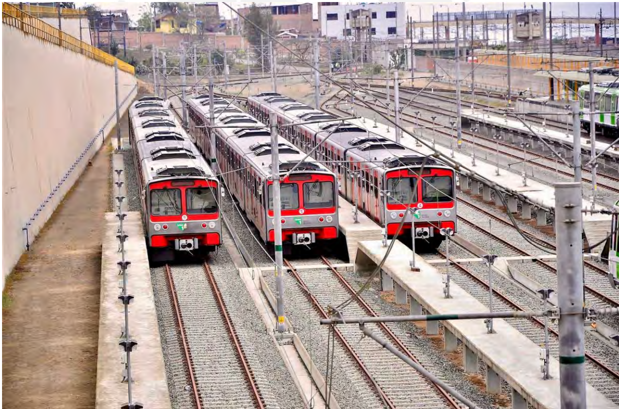
Fotografía: Parqueadero de trenes Villa El Salvador Fuente: OSITRAN
