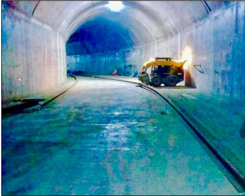
Posicionamiento de riel en túnel con minicargador
