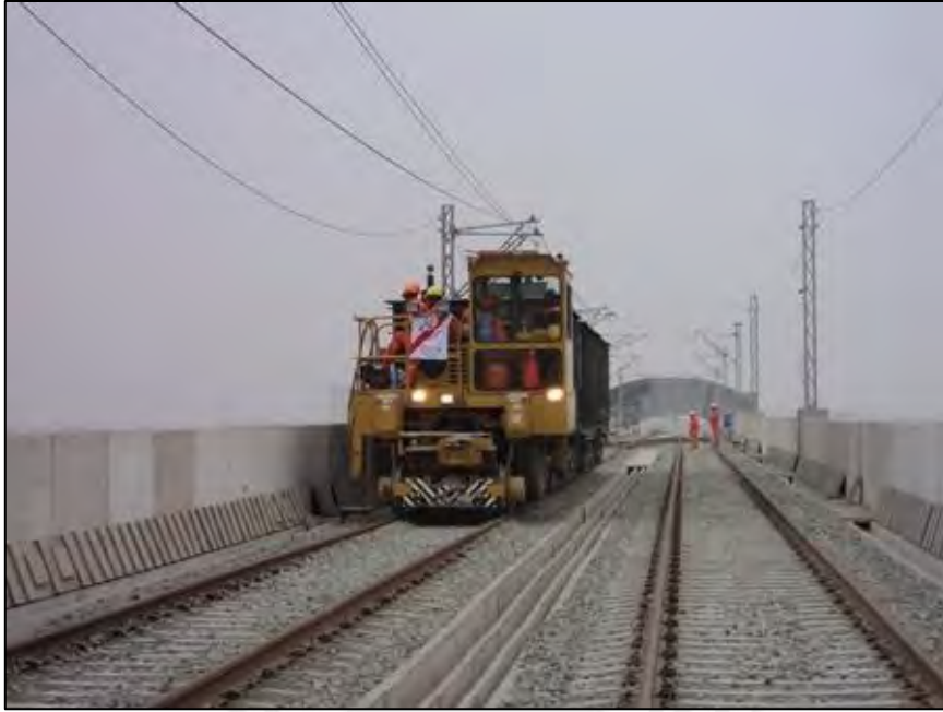
Fotografía: Titan con tolvas de balasto Fuente: Informe Mensual de Supervisión de Obra
