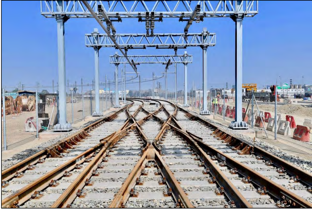
Fotografía: Vista aérea de desvío patio taller Fuente: Metro de Lima y Callao - News
