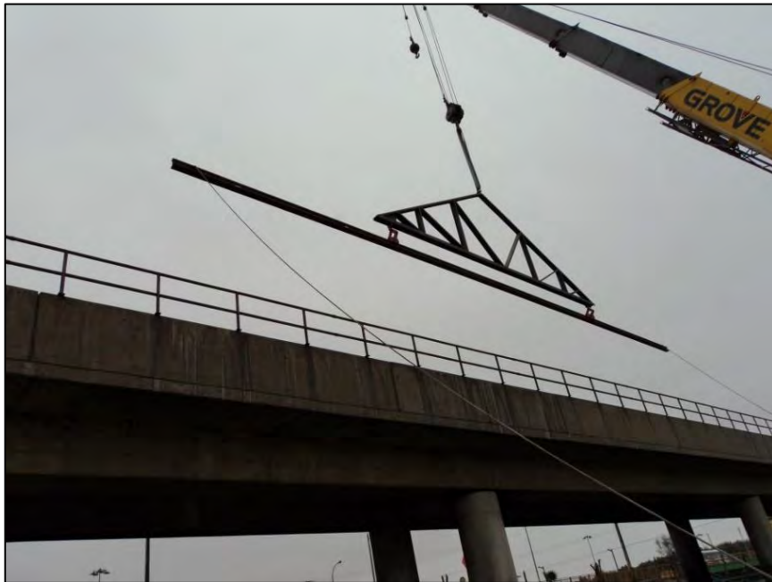
Fotografía: Izado de riel (Viaducto elevado) Fuente: Informe mensual de Supervisión
