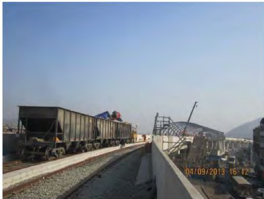
Fotografía: Vagones con balasto a completar (Viaducto Elevado) Fuente: Informe Mensual N27, 2013
