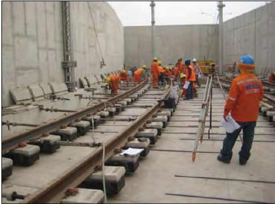
Fotografía: Verificación de geometría de vía Sistema Sonneville LVT Fuente: Informe Mensual de Supervisión de Obra
