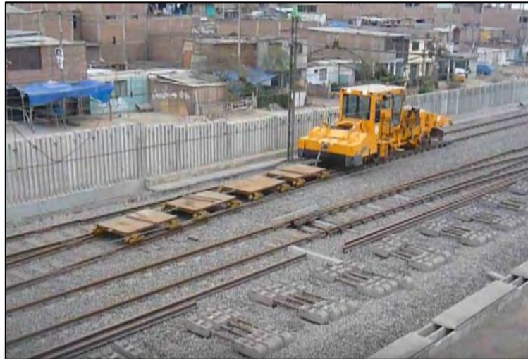
Figura 5.6: Reguladora con plataformas sobre la vía derecha y bloques retirados
