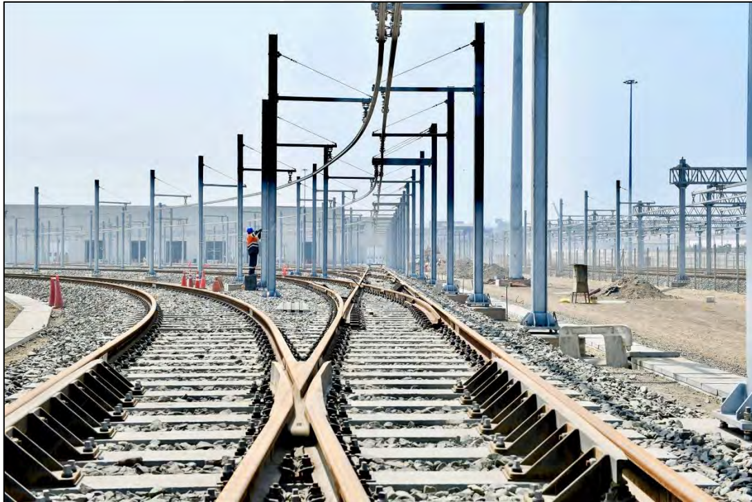
Fotografía: Desvío entrada a Taller de mantenimiento Fuente: Metro de Lima y Callao - News
