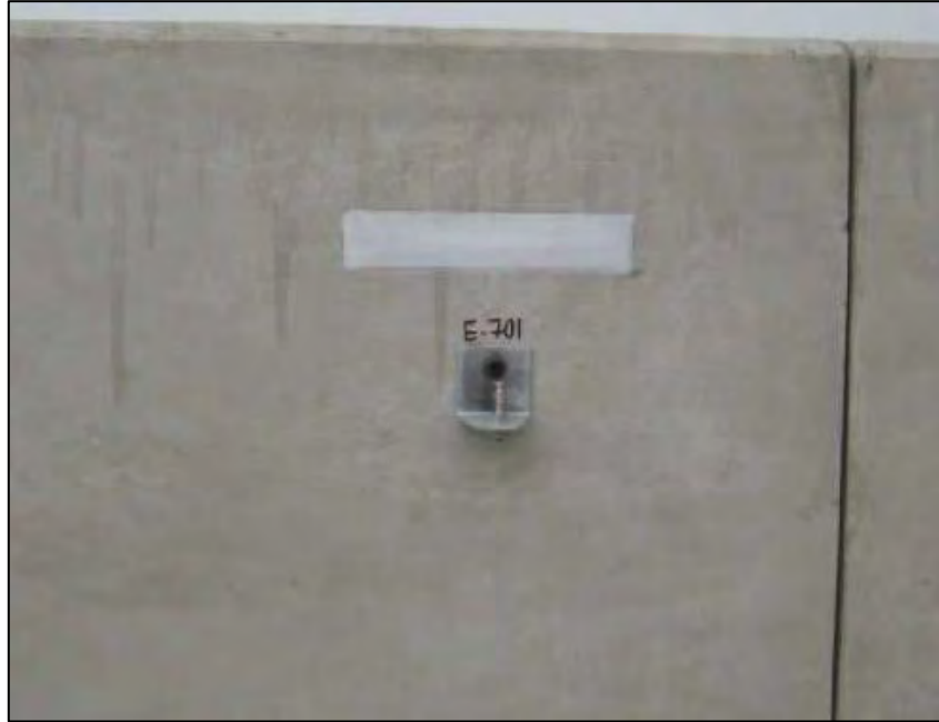
Fotografía: Punto topográfico en tablero elevado Fuente: Informe mensual de Supervisión
