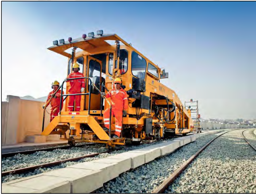
Fotografía: Bateadora de balasto Fuente: Informe mensual de Supervisión
