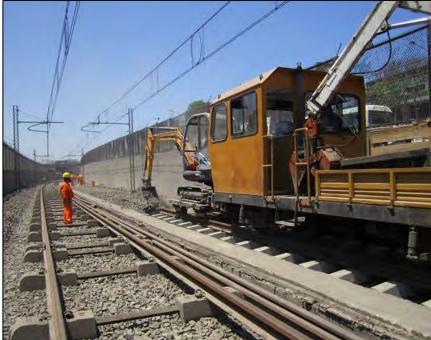
Fotografía A9.1: Colocación de balasto con pala mecánica Fuente: Informe mensual de Supervisión
