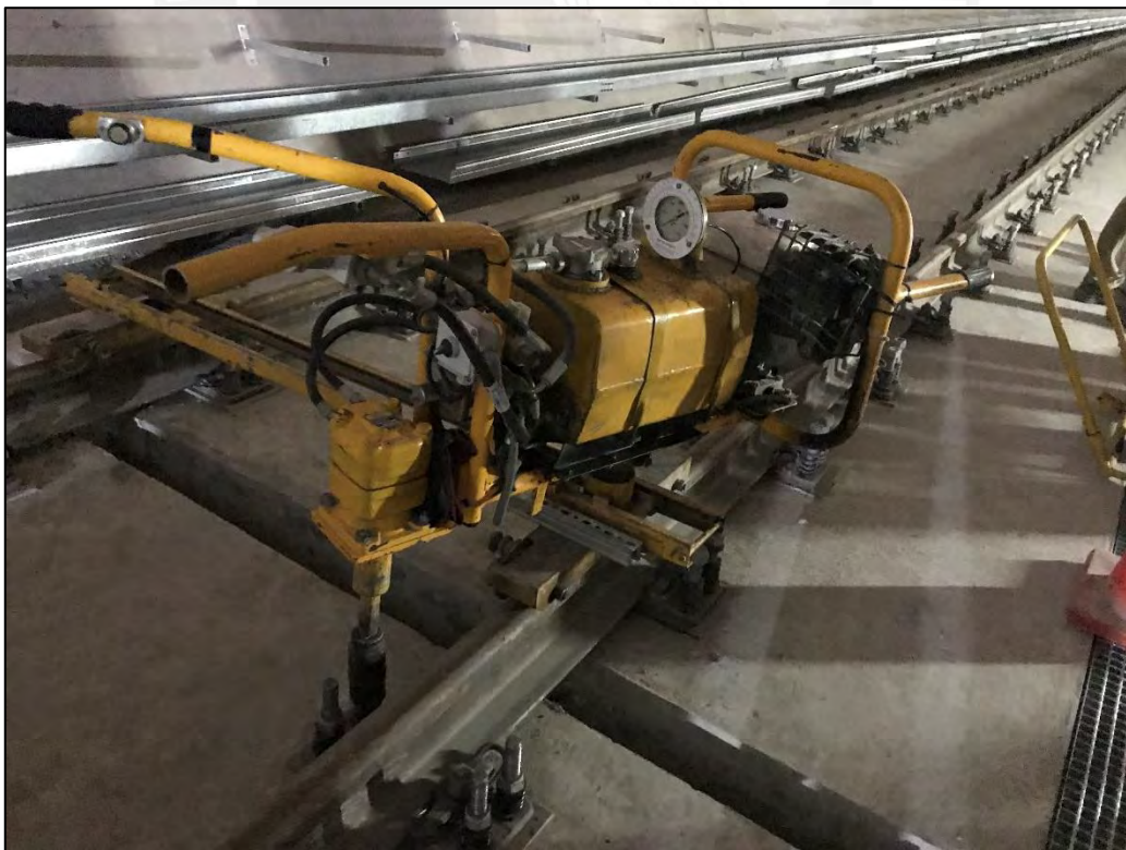
Fotografía: Ajuste de pernos final Fuente: Fotografía Propia
