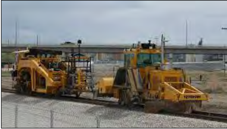
Fotografía: Bateadora y perfiladora de balasto Fuente: Informe mensual de Supervisión
