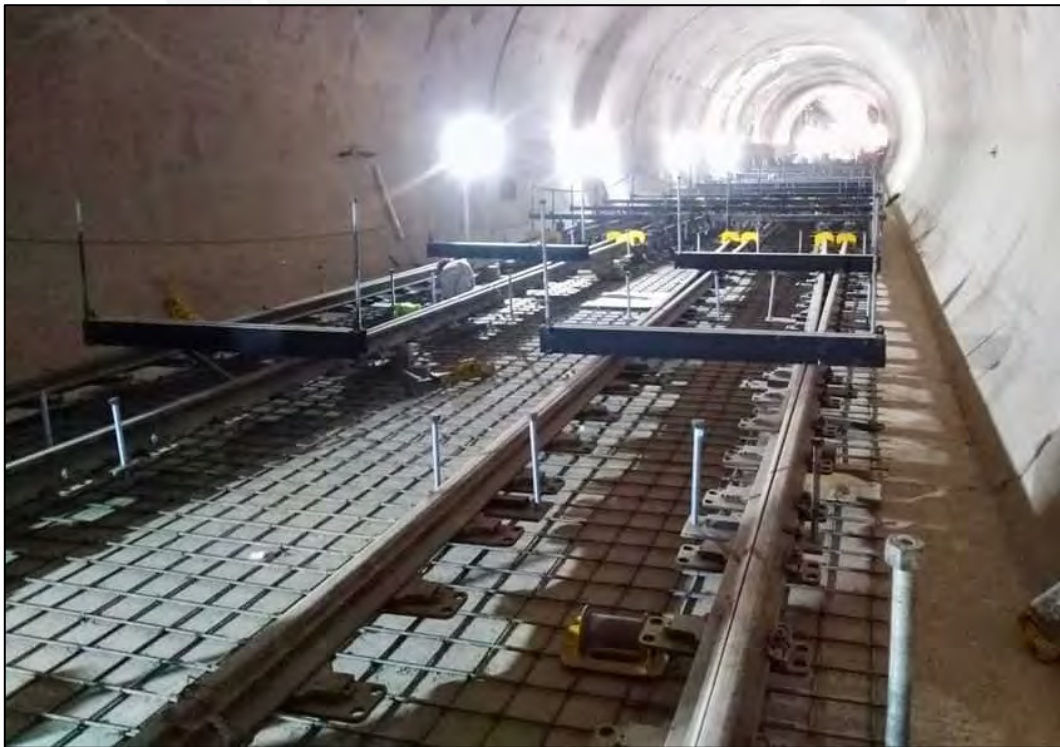
Fotografía: Falsas Traviesas montadas Fuente: Metro de Lima y Callao - News
