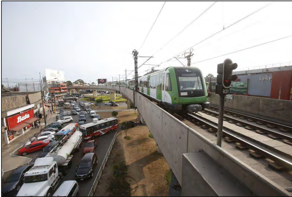
Fotografía: Tramo Sistema Soneville/LVT (Progresivas 12+267.221 a 12+588.685)
