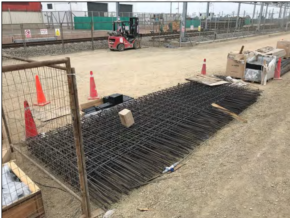
Fotografía: Acero para refuerzo para losa de vía en placa Fuente: Fotografía Propia
