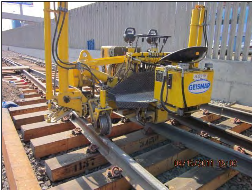
Fotografía: Track-Lifting Slew Machine Geismar en alineamiento de zona de cambia vías (durmientes de madera)
