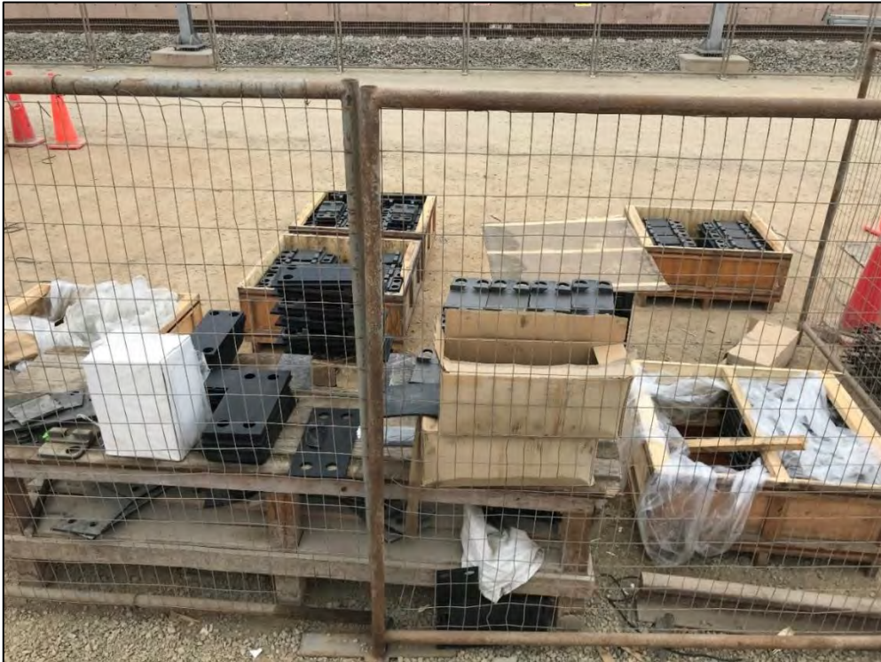
Fotografía: Mesa de Trabajo Ensamble de Sujeciones Vossloh Fuente: Fotografía Propia
