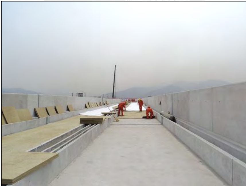
Fotografía: Colocación de sistema RockBallast sobre tablero de viaducto Fuente: Informe mensual de Supervisión
