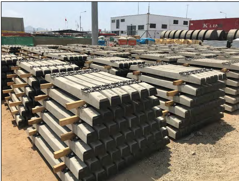
Fotografía: Acopio de durmientes Fuente: Fotografía Propia
