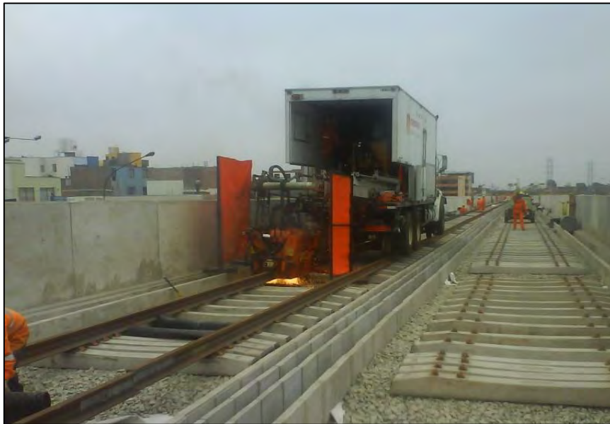
Fotografía: Soldadura Eléctrica (Viaducto Elevado) Fuente: Informe mensual de Supervisión
