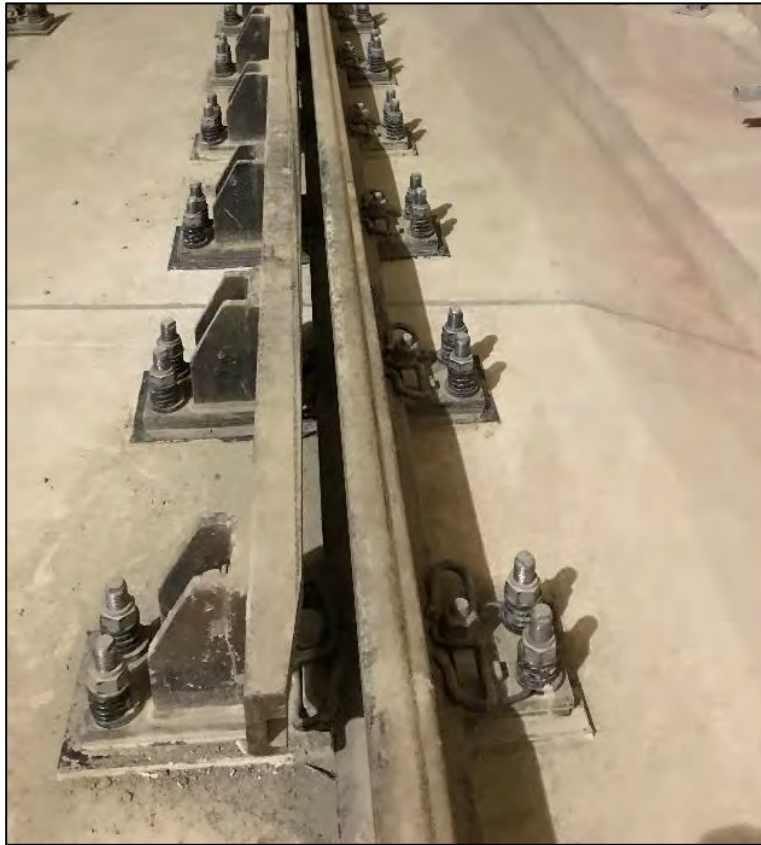
Fotografía: Contrarriel Tipo 33C1 en cambio de vía Fuente: Fotografía Propia
