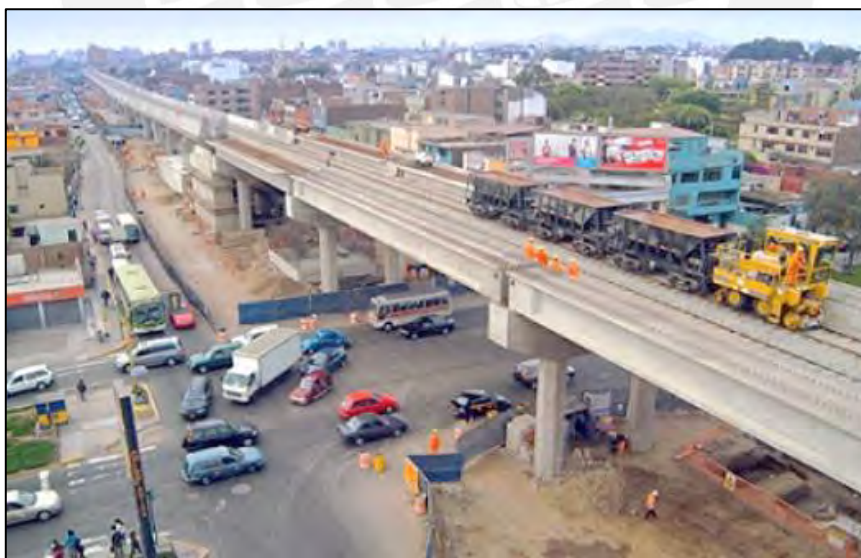
Fotografía: Vagones con balasto a completar (Viaducto Elevado) Fuente: Informe mensual de Supervisión
