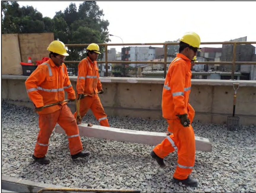
Acarreo de durmiente de forma manual con tenazas (Viaducto Elevado) Fuente: Informe mensual de Supervisión
