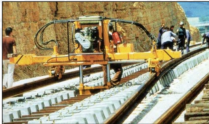
Figura 4.5: Carro colocador de Rieles MPR [Alineadora]
