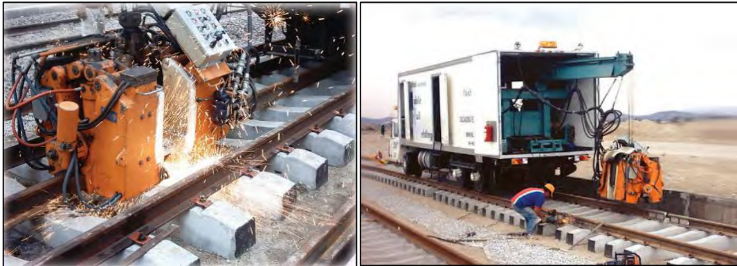
Figura 4.12: (a) Soldadura eléctrica de riel; (b) Camión de soldadura
