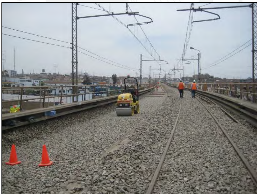
Fotografía: Compactación de primera capa de balasto (Viaducto Elevado) Fuente: Informe mensual de Supervisión
