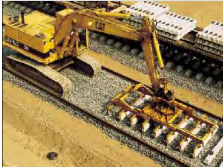
Figura 4.4: Retroexcavadora con Porta durmientes
