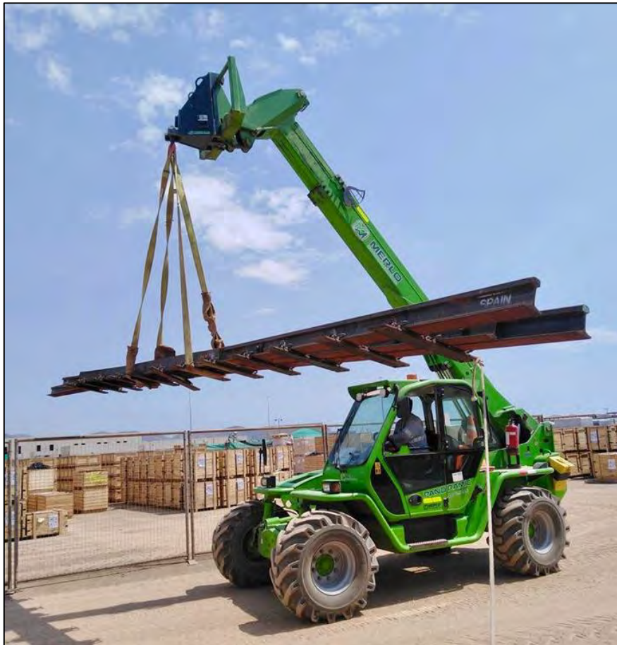
Fotografía: Izaje y acarreo de desvíos Fuente: Metro de Lima y Callao - News
