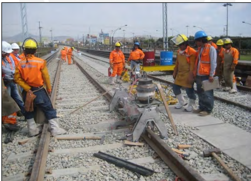
Fotografía: Soldadura aluminotérmica (Viaducto Elevado) Fuente: Informe mensual de Supervisión
