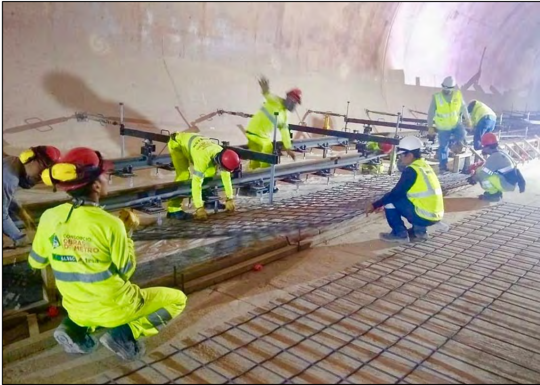
Fotografía: Instalación de acero de refuerzo
