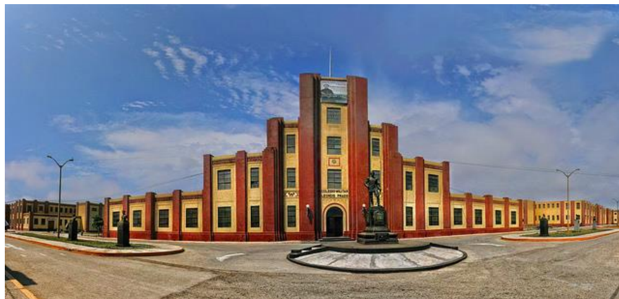
Figura 3-3: Fachada del Colegio Leoncio Prado
