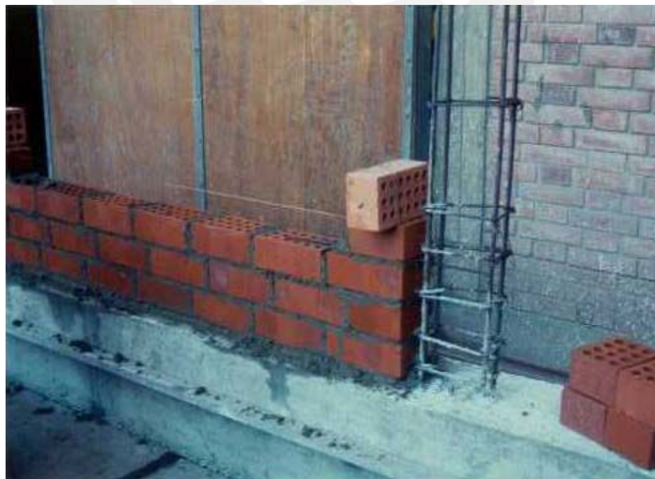
Fig. 5.4 Asentado de ladrillos, puede notarse el ladrillo maestro y el cordel.
