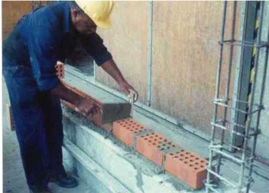
Fig. 5.3 Asentado de ladrillos; relleno de juntas verticales con mortero de proporción 1:4 (cemento: arena).
