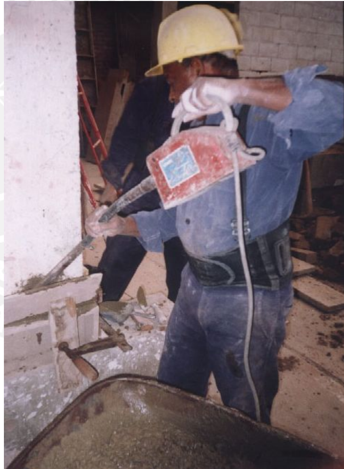
Fig. 8.11 Vibrado del concreto de reparación.
