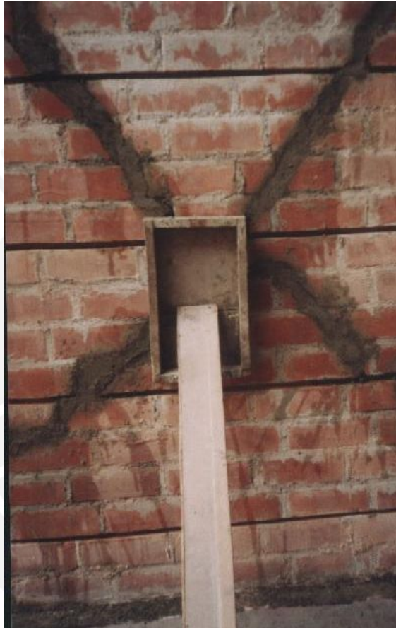
Fig. 8.13 Encofrado de una de las caras del muro en la región central de la albañilería.
