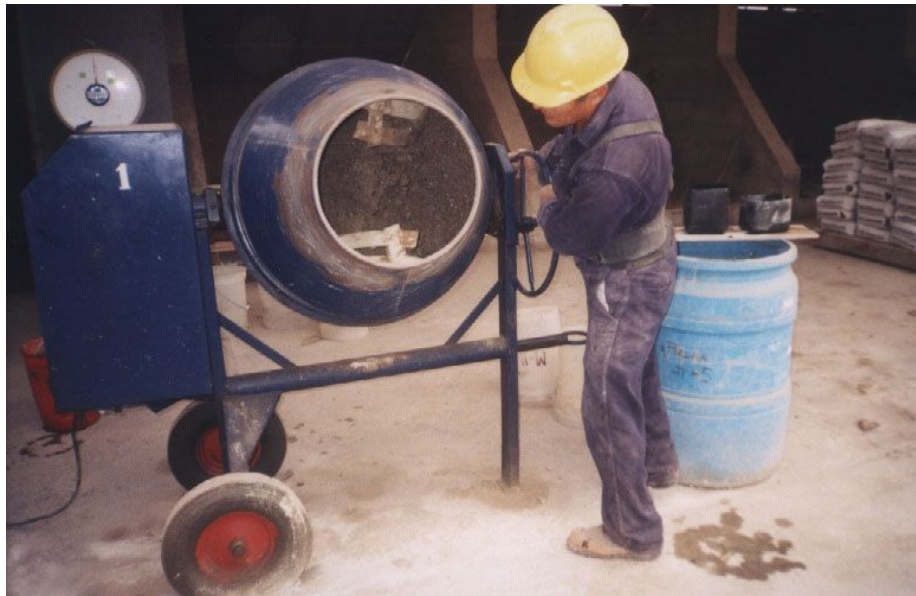
Fig. 3.2 Preparación del concreto.
