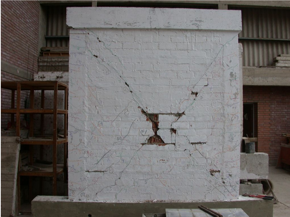
Fig. 10.8 Muro reparado después del ensayo.
