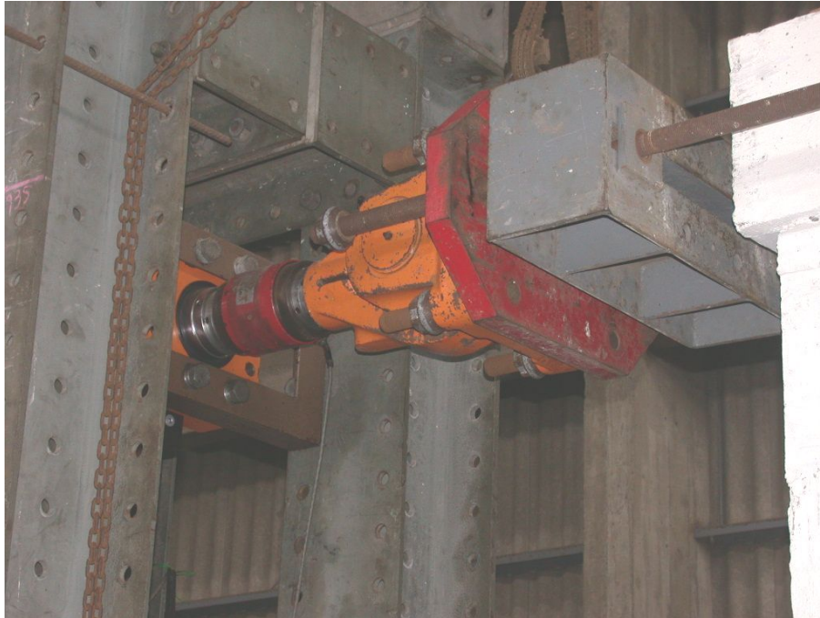
Fig. 6.5 Tirantes horizontales colocados a la altura de de la viga solera.
