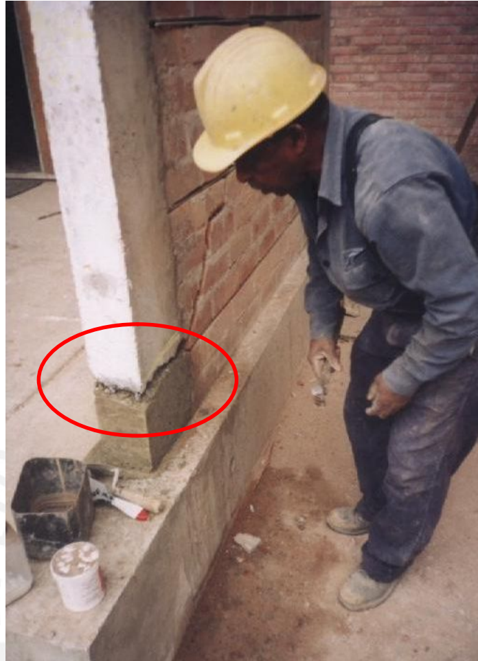
Fig. 8.12 Zona de la cangrejera. Su reparación se hizo con mortero y resina epóxica simple en polvo.
