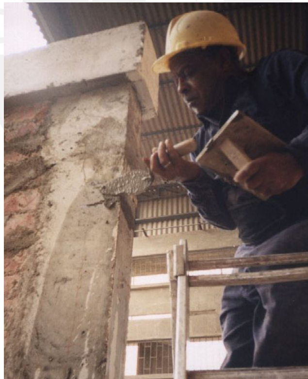
Fig. 8.18 Con un frotacho y un badilejo se procedió al sellado de las fisuras en las columnas.
