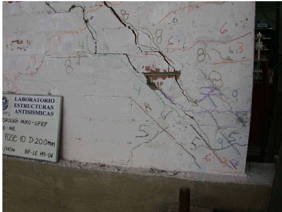
Fig. 10.7 La adherencia entre las varillas de GFRP y la cama de mortero se perdió en distintas zonas del muro.
