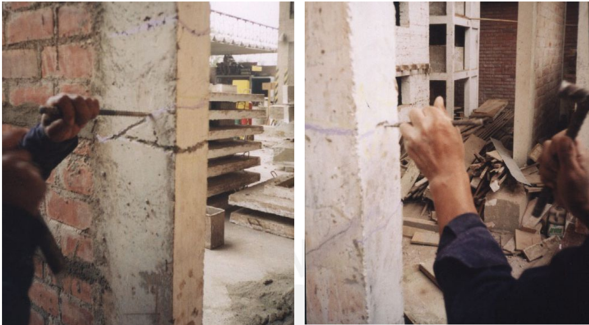
Fig. 8.17 Reparación de grietas importantes en las columnas.
