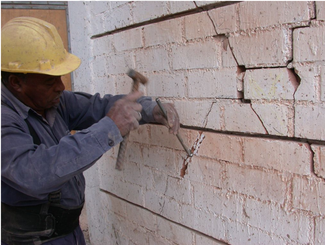
Fig. 8.6 Picado de fisuras importantes en la albañilería. La profundidad es de aproximadamente 1.5 cm.
