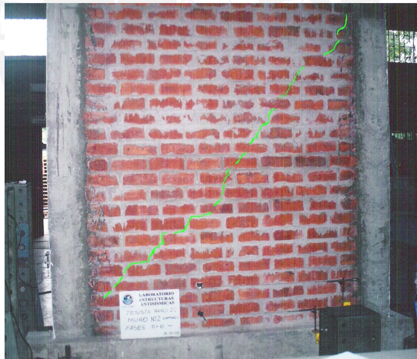
Fig. 7.3 Vista de la parte posterior del muro luego de la Fase 6 ( D= 10\text{mm} ). Se puede apreciar la grieta diagonal del muro con tamaños de hasta 5mm, la grieta ha sido pintada en la foto con color verde para poder apreciarla mejor.
