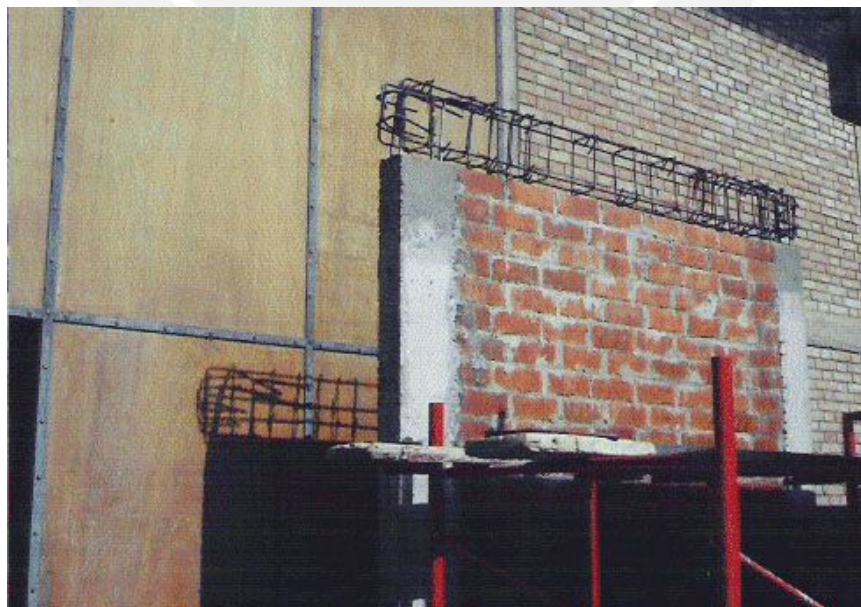
Fig. 5.6 Armadura de viga solera lista para el encofrado.
