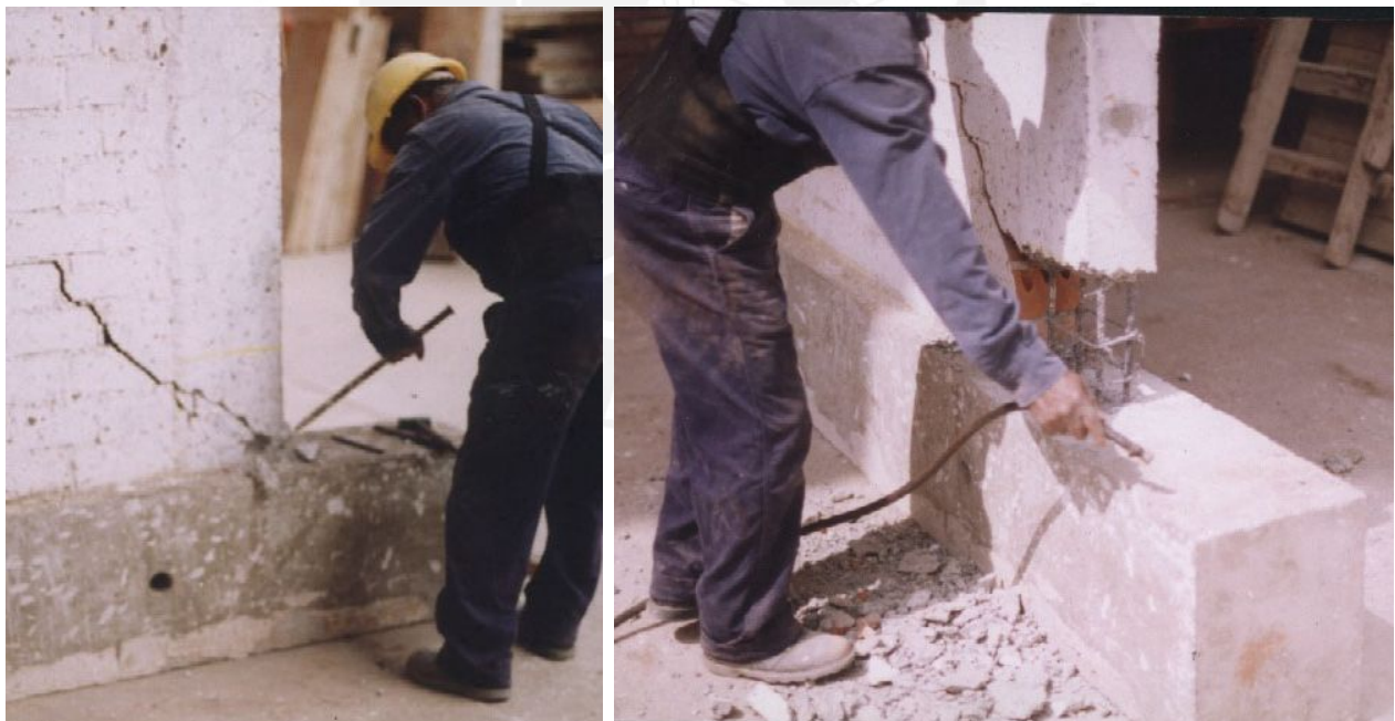
Fig. 8.4 Picado del concreto con comba y cincel (Izq.); compresor de aire para limpieza de zona trabajada (Der.).
