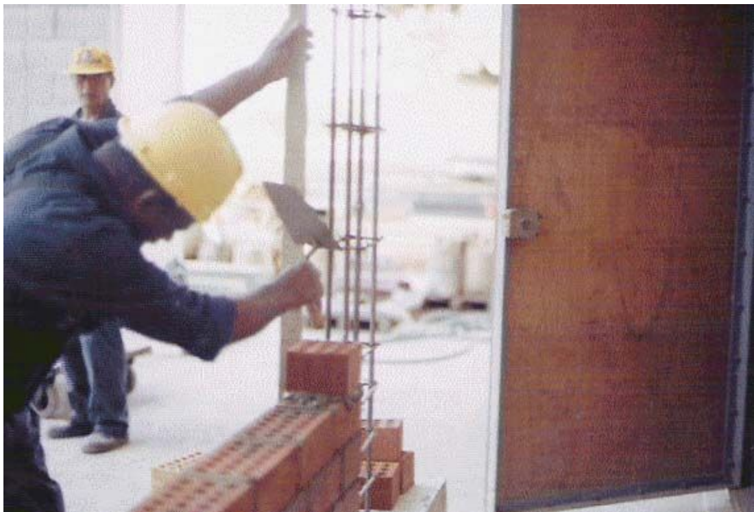
Fig. 5.2 Los estribos de la columna fueron colocados y ajustados antes del levantamiento de la albañilería.
