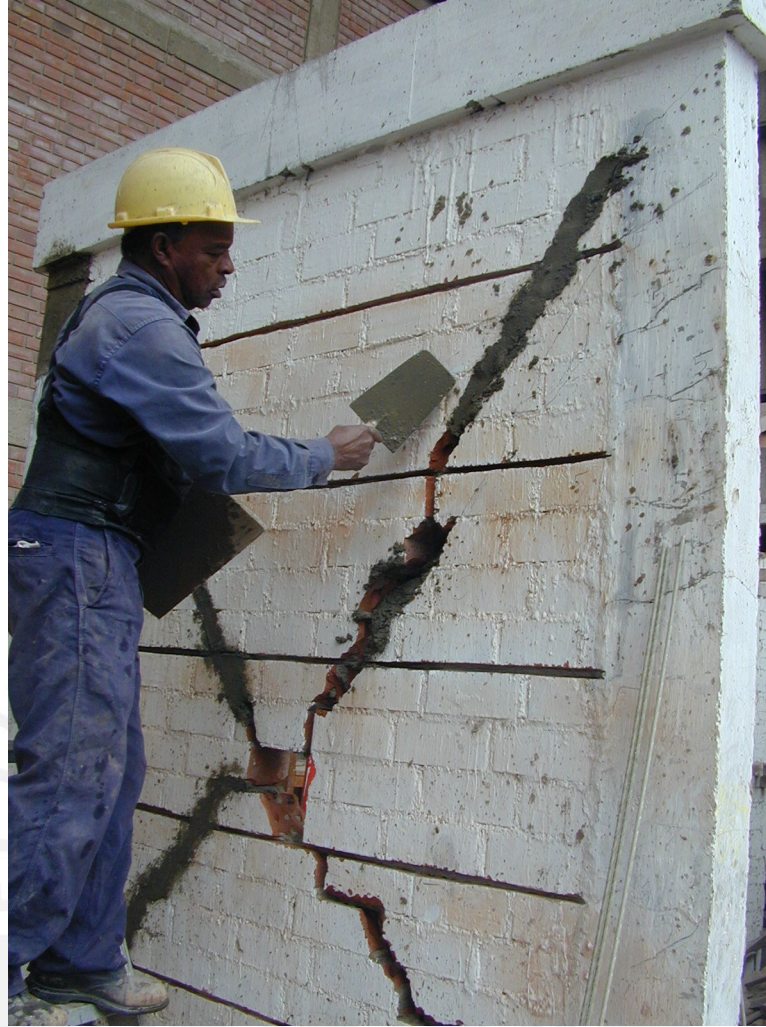
Fig. 8.7 Sellado de grietas con mortero 1:4.
