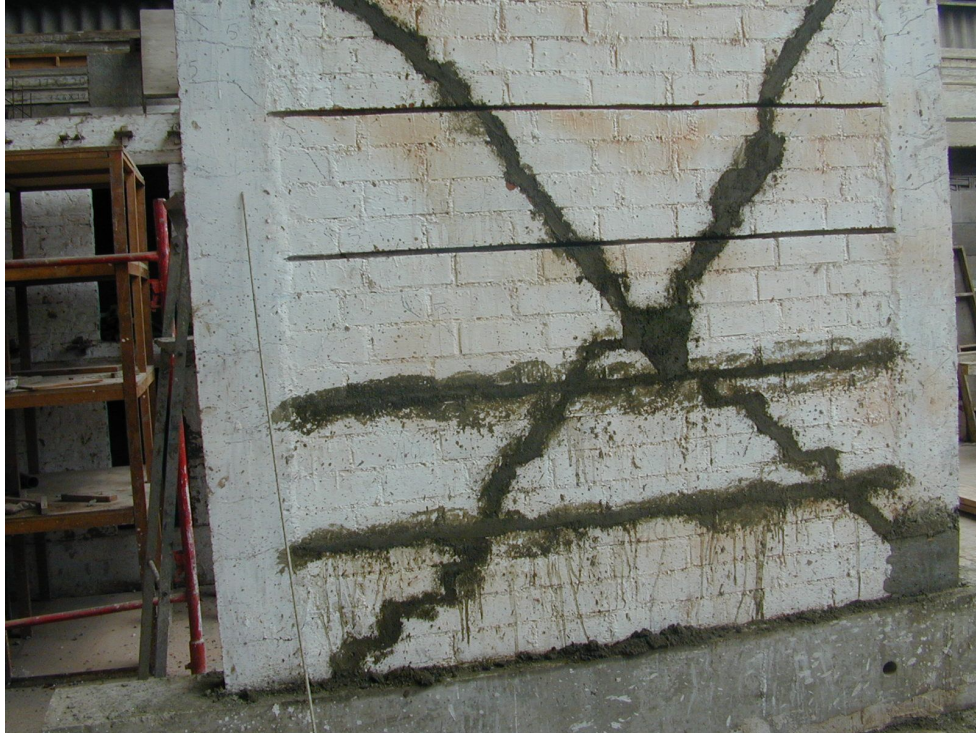
Fig. 8.16 Una vez instalada la varilla, se procedió a recubrirla con mortero 1:4 y a dejar un acabado al ras del muro de albañilería.
