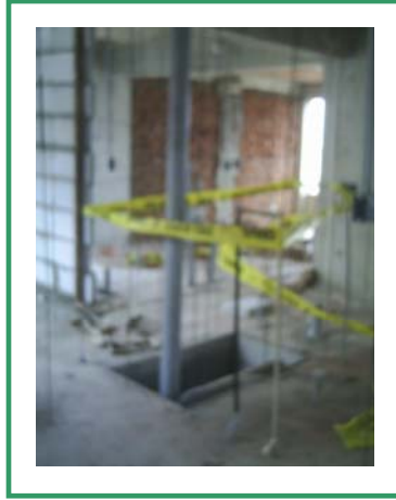
Falta de señalización en vano de ascensor, instalaciones.
