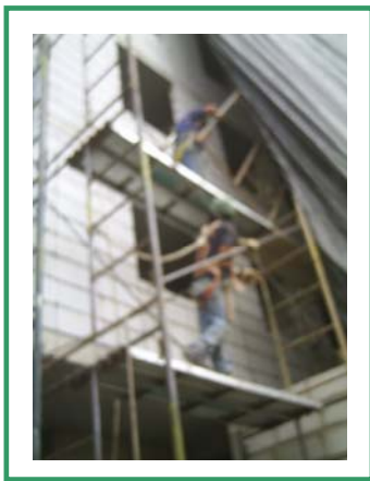
Uso de andamios para trabajos en altura.
