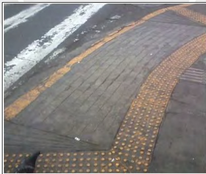
Figura 4.7 Presencia de baldosas de prevención en los cruces peatonales. Fuente: propia
