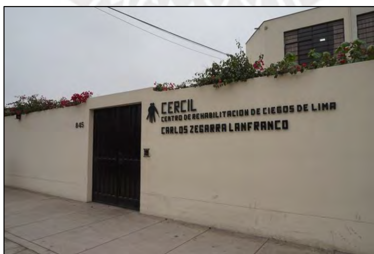
Figura 4.28 Falta de señalización en CERCIL, Santiago de Surco. Fuente: CERCIL (2015)
