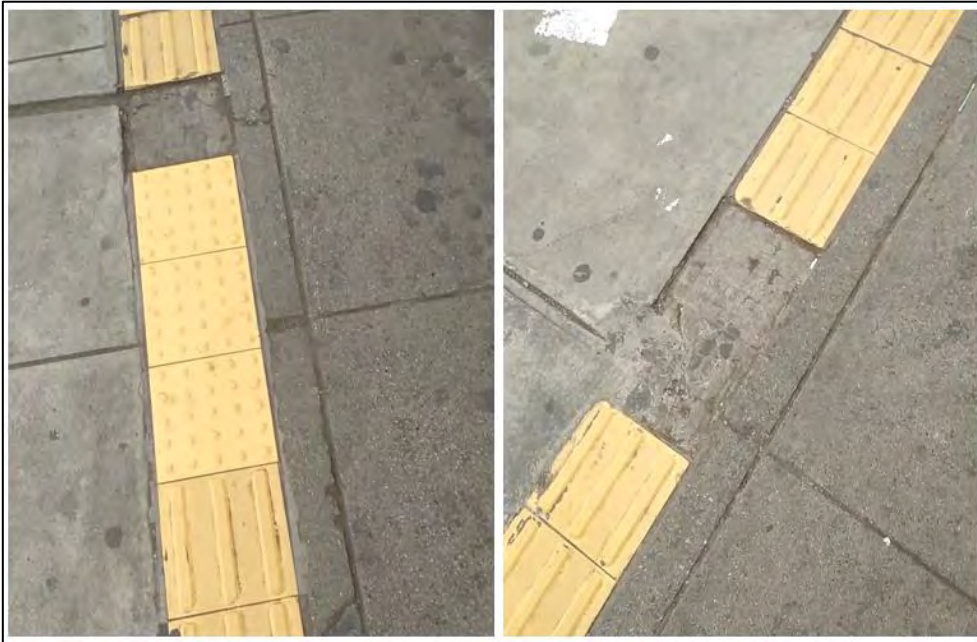
Figura 4.12 Utilización de baldosas inapropiadas en el tramo y presencia de discontinuidades. Fuente: propia
