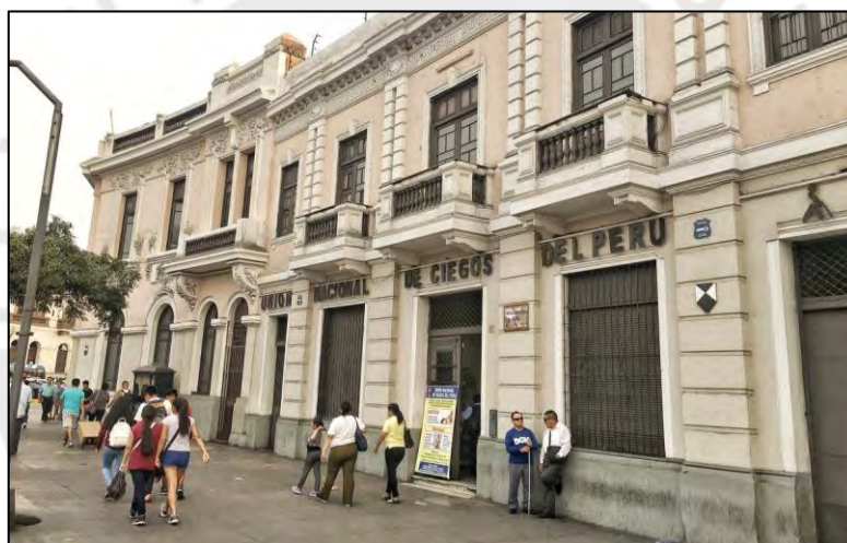
Figura 4.27 Falta de señalización en la UNCP en Plaza Bolognesi. Fuente: Street View (2016)
