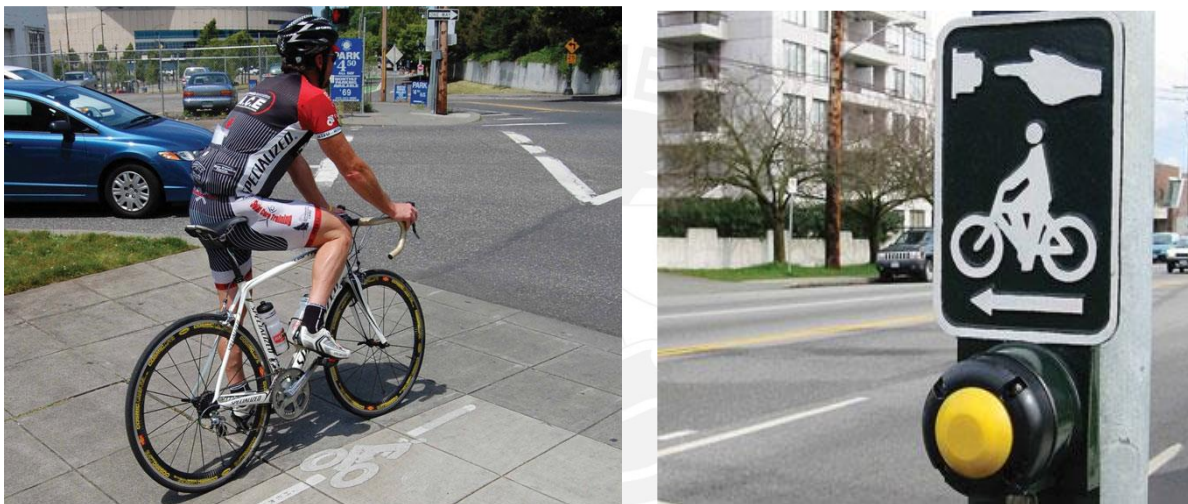
Figura 20 : Detección automática en el suelo de una ciclovía interurbana en cruce de avenida. A la derecha, detección por medio de botón Portland- Orlando.
