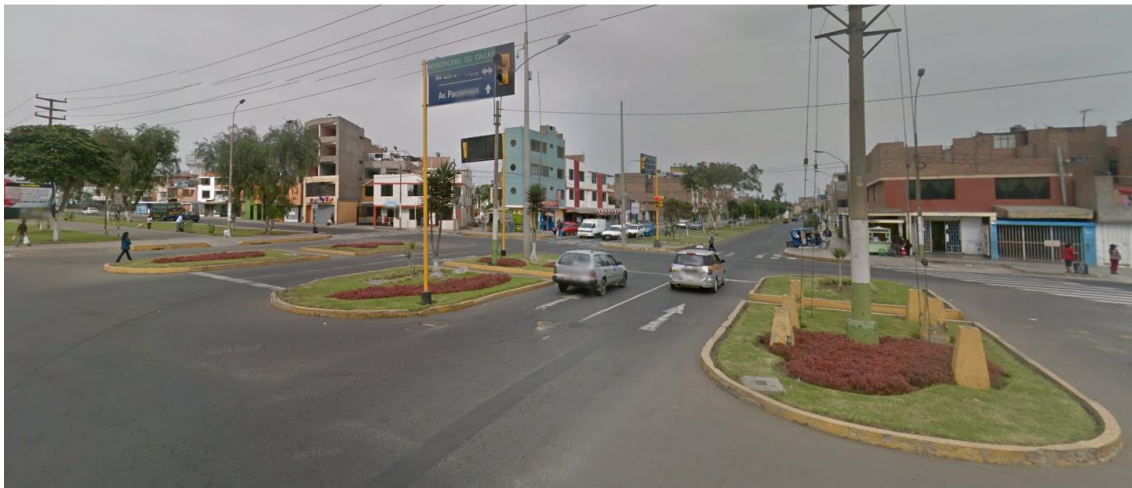
Figura 19 : Refugio que se presenta en dos tramos en ruta interurbana de la Av. Colonial. Lima- Perú.
