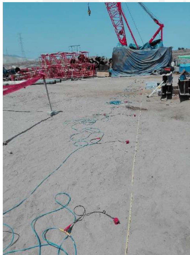
Fotografía 02: Se observa la instalación del equipo y el tendido de los cables sobre el terreno.
