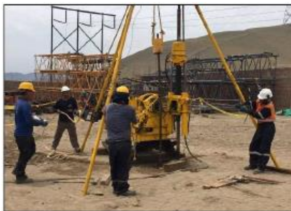
Figura 3.3: Ensayo SPT en Chilca
