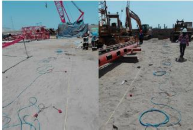
Figura 3.5: Vista general del tendido del cable refracción y posicionamiento de geófonos
