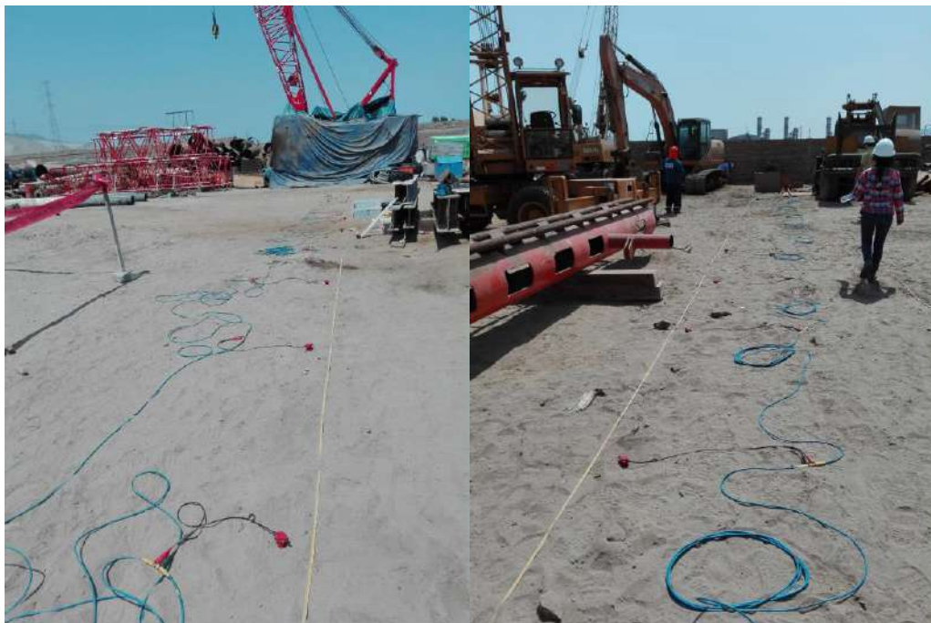
Figura 2.7. Vista general del tendido del cable refracción y posicionamiento de geófonos.
