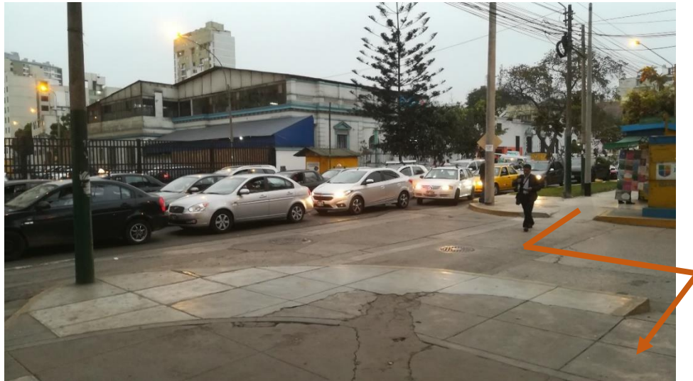
Figura 52. Discontinuidad de vía para personas de movilidad reducida
