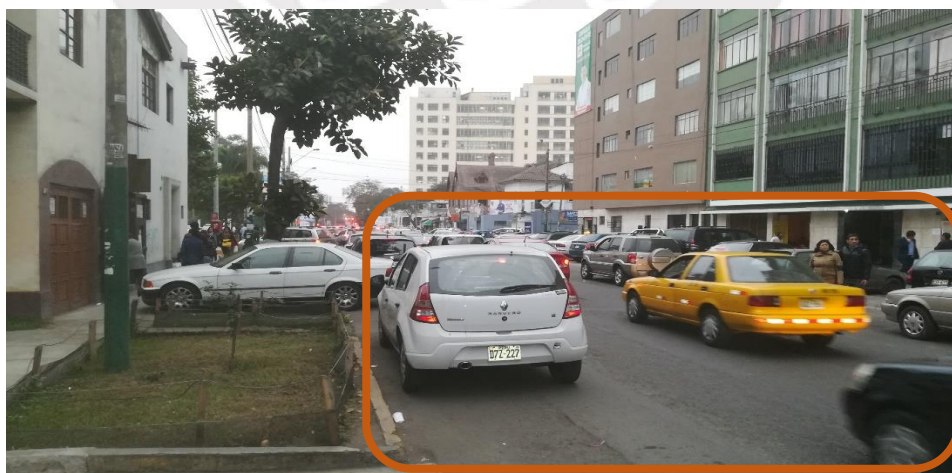
Figura 51. Falta de mantenimiento en señalización horizontal
