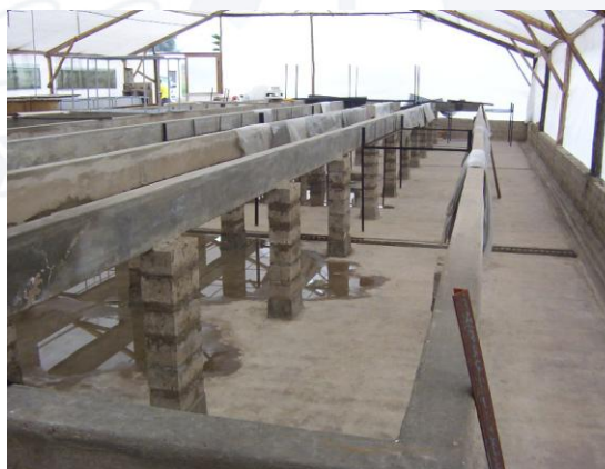
Figura 4-4 Cama de cemento en proceso de construcción
