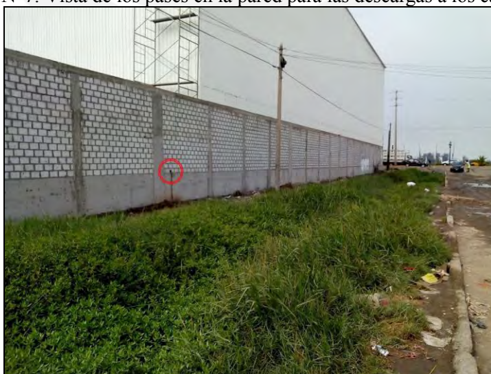
Foto N°7: Vista de los pases en la pared para las descargas a los canales.
