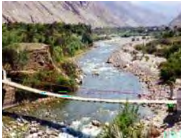
Figura 40. Puente colgante de Catapalla
